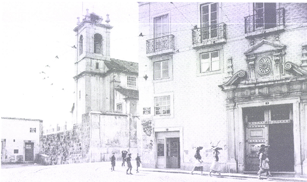
Fig. 2.2 - O Largo das Portas do Sol antes das demolições dos edifícios (canto esquerdo da fotografia) fronteiras ao Palácio Azurara. (Arquivo Fotográfico da CML)
