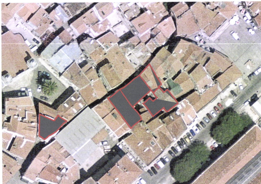
Fig. 4.2 - Fotografia aérea da Rua de São Pedro com os 2 edifícios do conjunto C e os 4 do conjunto L assinalados a vermelho (arquivo da UPA-CML).
