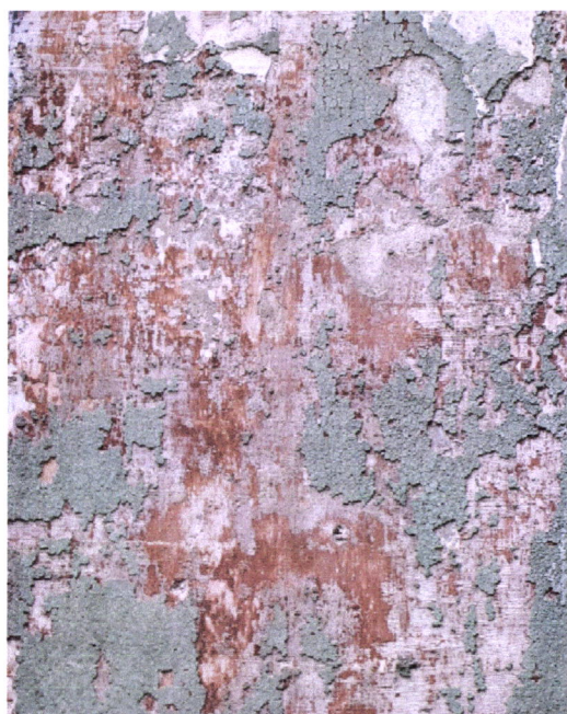
Fig. 4.19 - Fachada na Rua de São Pedro (L46).
