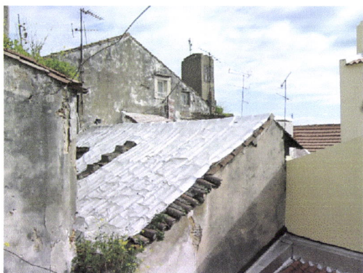
Fig. 4.20 - Parte de cobertura (L43A).
