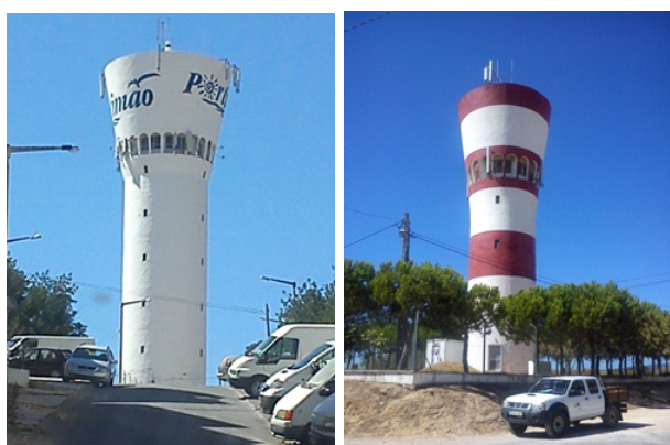
Figura 3.2 - Reservatórios elevados de Boavista e de Bemposta © Cristiano Gregório (2014)
