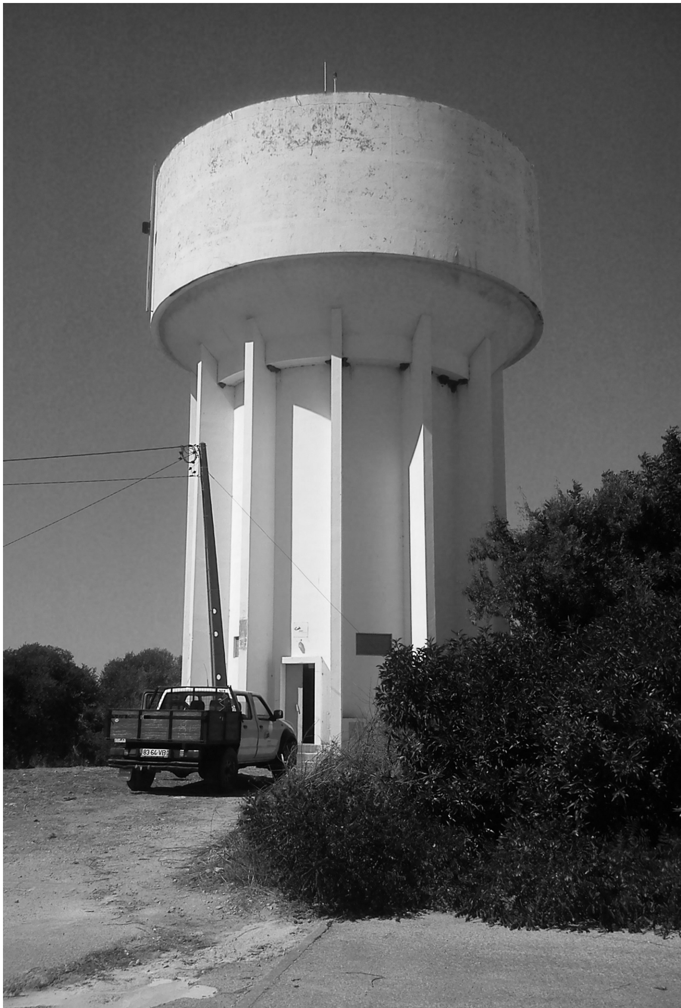
Reservatório elevado da Figueira © Cristiano Gregório (2014)
