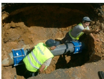
Figura 2.15 - Rotura e substituição de troço de conduta DN 315 © EMA/RF (2012)
