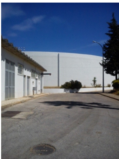
Figura 3.3 - Reservatório elevado e reservatório apoiado da Grande Reserva de Chão das Donas. © Cristiano Gregório (2014)
