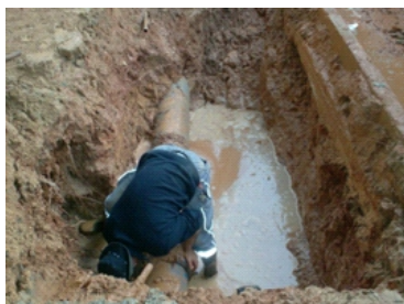
Figura 2.15 - Rotura e substituição de troço de conduta DN 315 © EMA/RF (2012)
