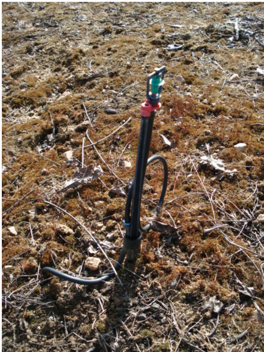
Figura 34 – Aspecto de um microaspersor
