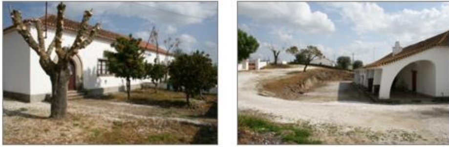
Figura 4. 2 – Vista geral da fachada principal e da fachada posterior do edifício.
