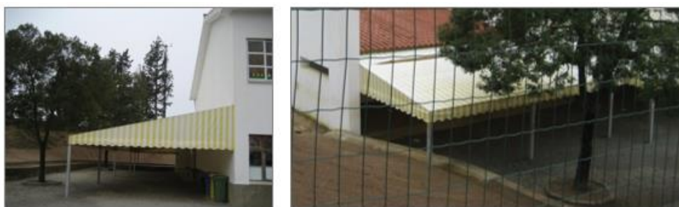
Figura 4. 16 – Vista geral da Fachada Lateral Esquerda.
