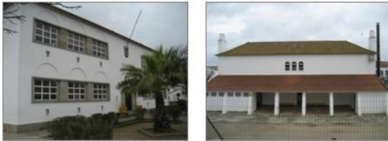
Figura 4. 12 – Fachada Principal e Fachada Posterior.
