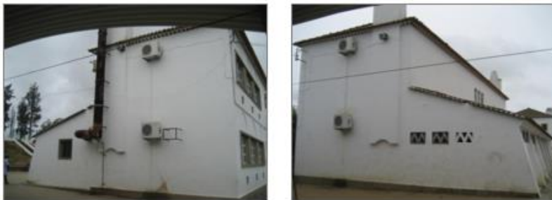
Figura 4. 13 – Fachada lateral Esquerda e Fachada lateral Direita.
