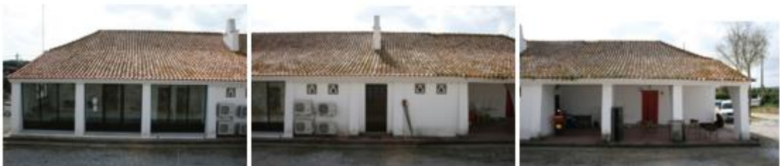
Figura 4. 5 – Fachada posterior na sua totalidade.
