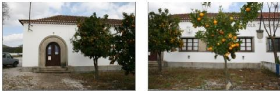
Figura 4. 3 – Zona de acesso e vãos de peito da fachada principal.
