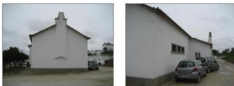
Figura 4. 19 – Fachada Lateral Direita.
