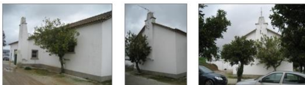
Figura 4. 20 – Fachada Lateral Esquerda.
