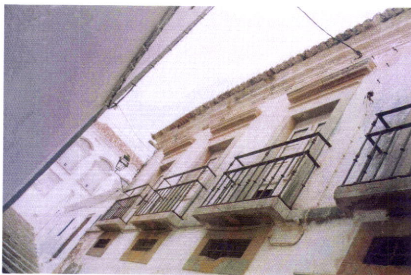
Primeiro piso da Casa da Administração (janelas da antiga sala de Biblioteca). No piso térreo esteve instalado inicialmente o Museu Municipal (Marco Lopes)
