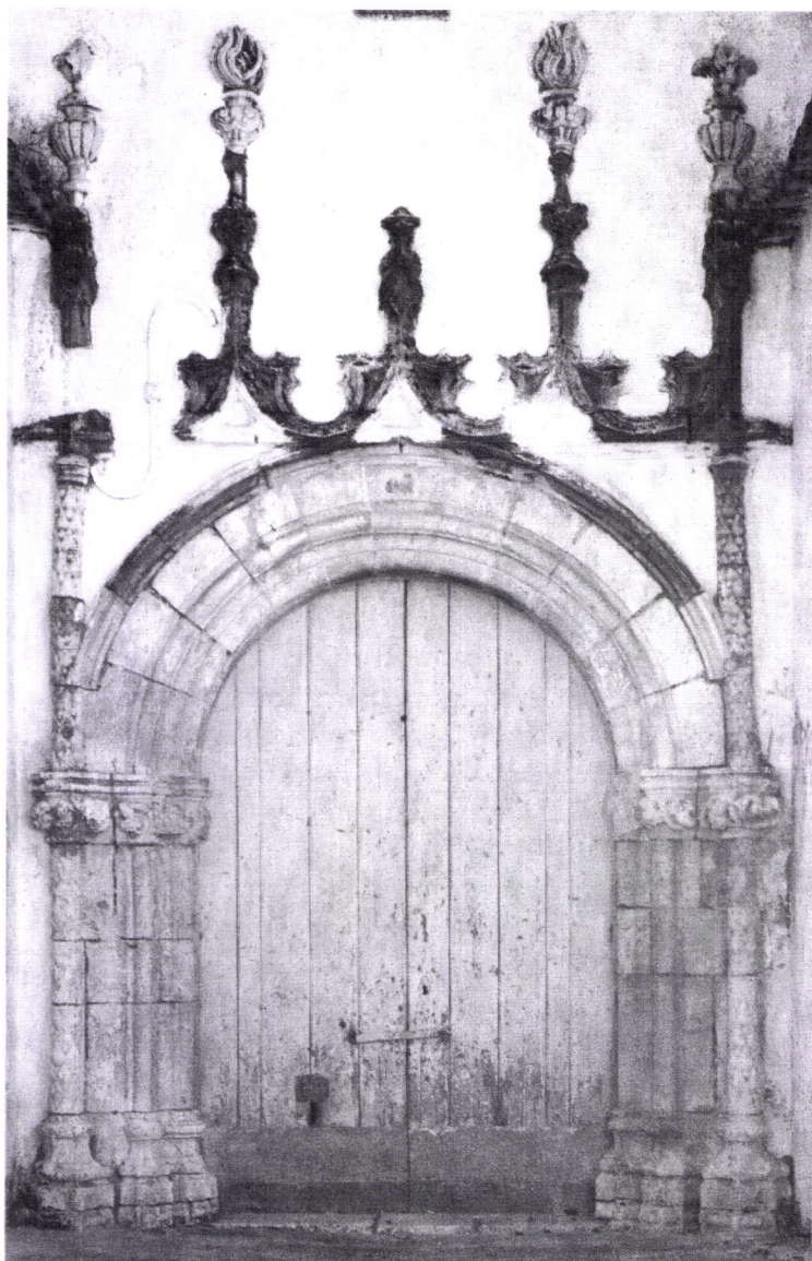
Portal Manuelino do antigo Convento das Bernardas (Arquivo Histórico Municipal)
