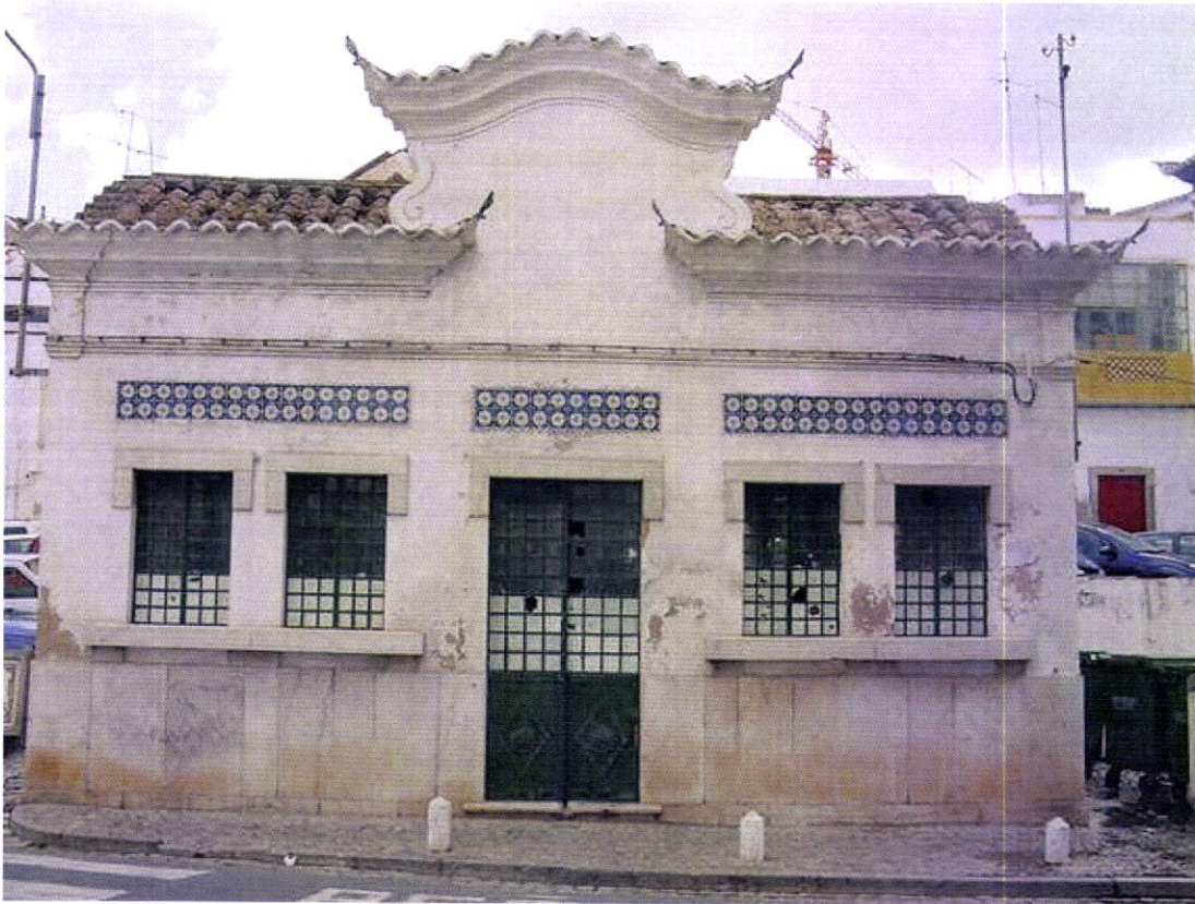
Fachada principal da antiga Estação Elevatória das Águas (Câmara Municipal de Tavira)
