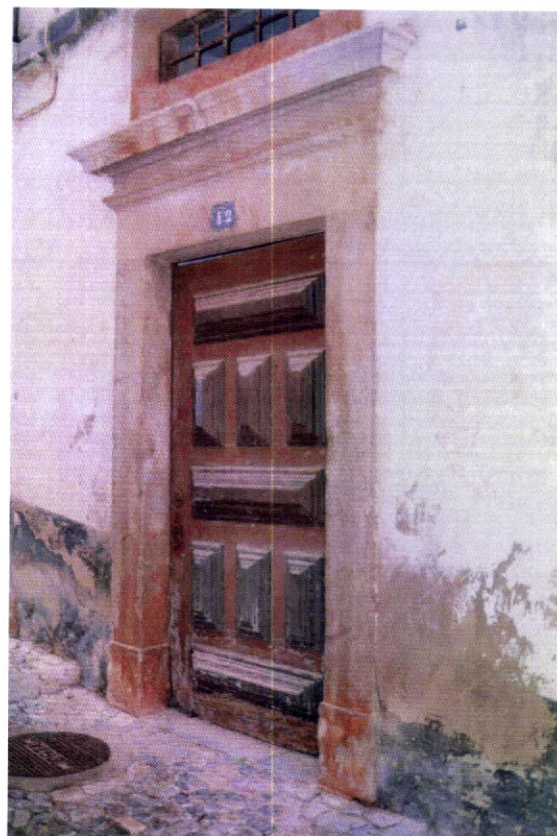
Porta de acesso às dependências anexas da Igreja da Misericórdia (Marco Lopes)
