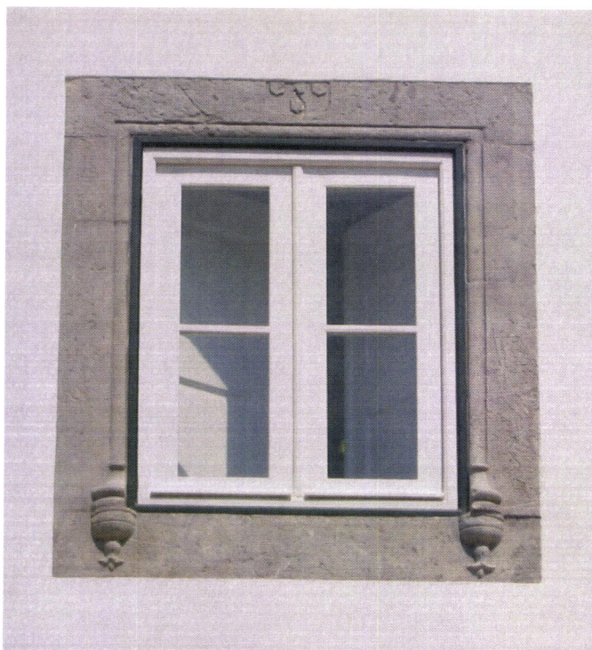
Janela Renascentista - Rua da Liberdade (Câmara Municipal de Tavira)
