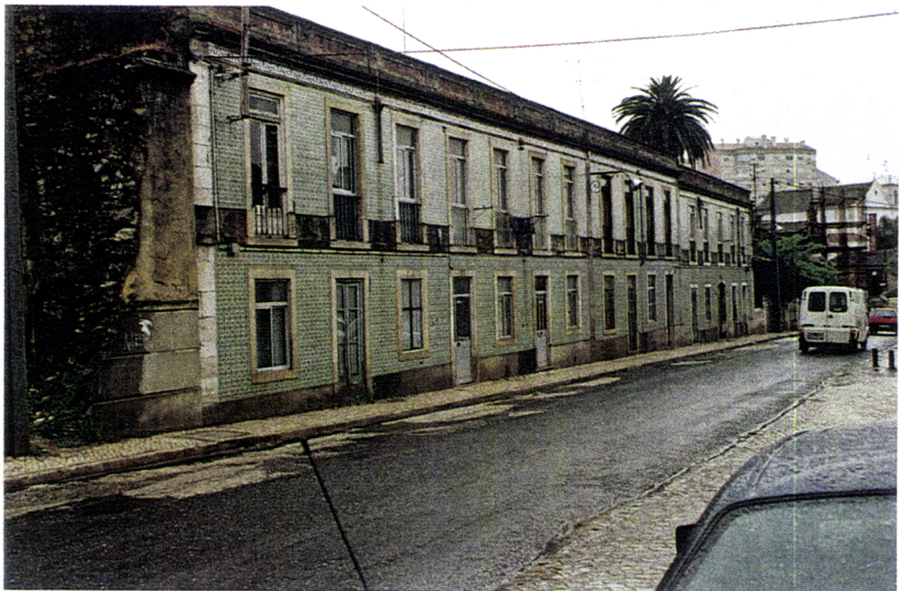
Fot. 47 a 49 - Tipologias Edificatórias: Rua Guilherme Gomes Fernandes e Rua Combatentes da Grande Guerra
