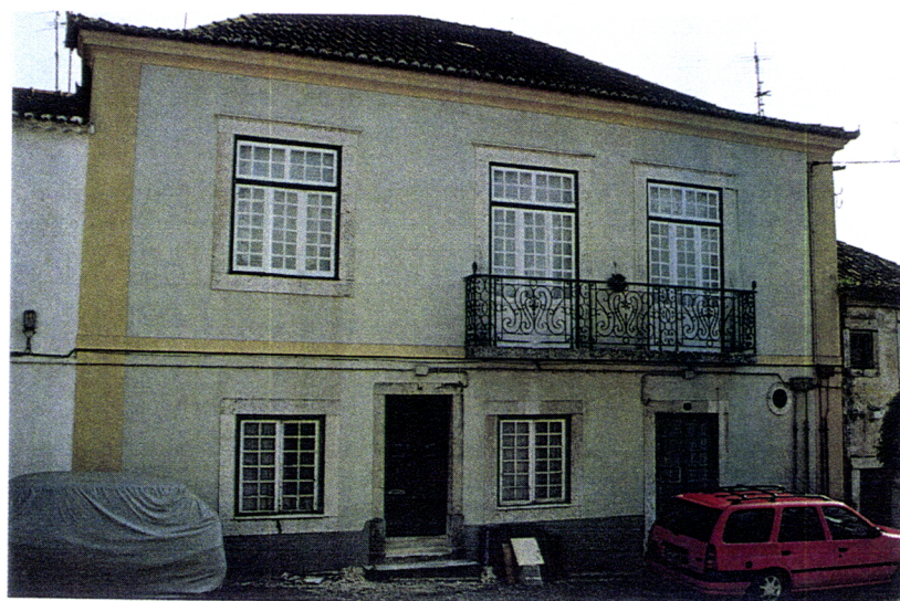
Fot. 44 a 46 - Classificação do Edificado: Mosteiro (M.N.) - A; Casa do Pároco - C, e Edifício de Interesse no Conjunto Urbano - D
