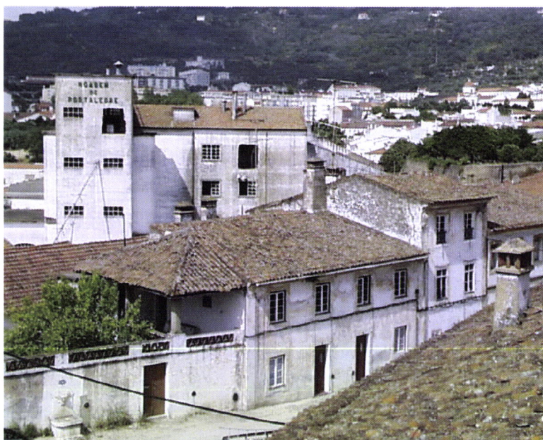
Figura 50 - Aspecto dos edifícios a demolir na rua 1º de Maio
