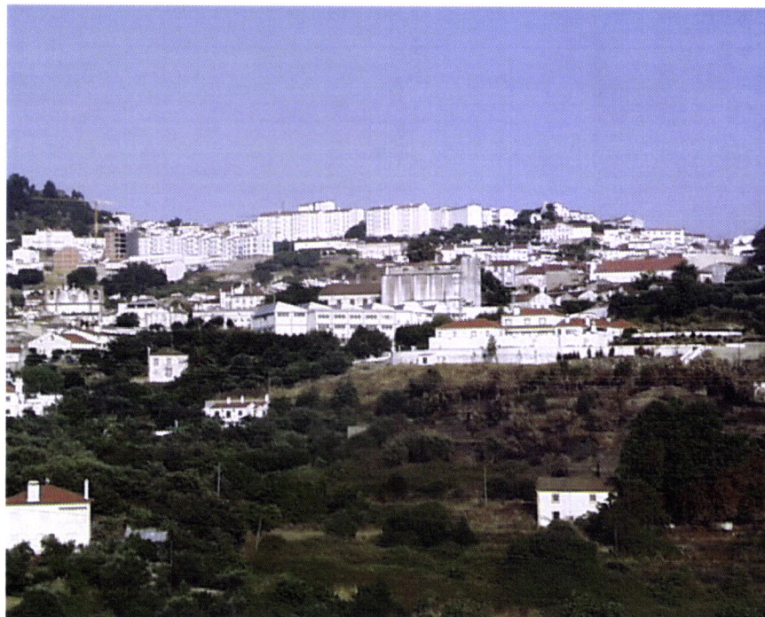
Figura 49 - Aspecto geral e envolvente do edifício da antiga Moagem de Portalegre
