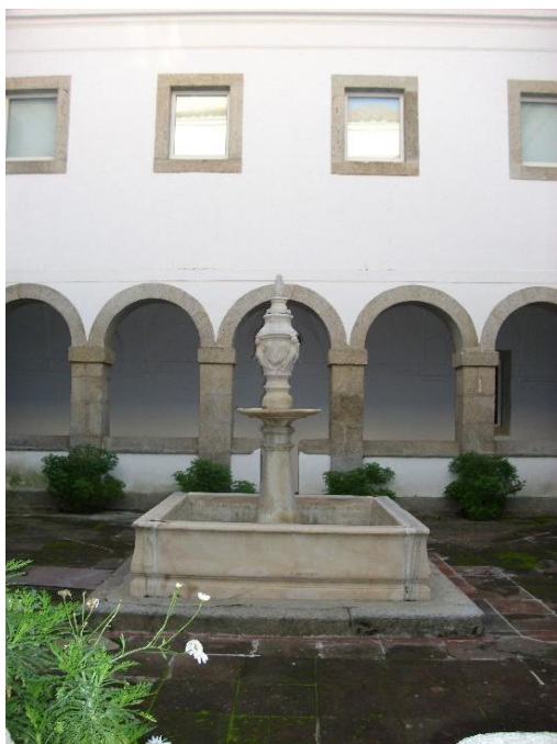
Foto 33 - Convento de Nossa Senhora dos Remédios, claustro.
