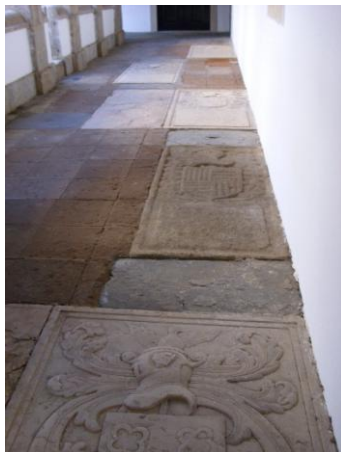
Foto 35 - Convento de Nossa Senhora dos Remédios, claustro
