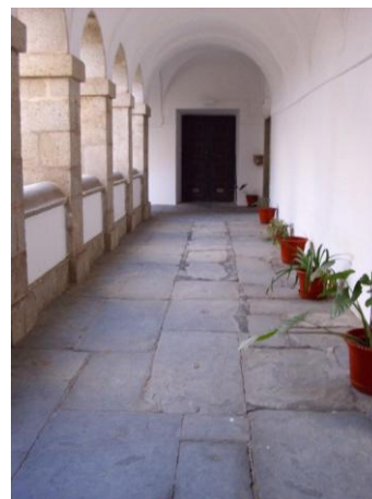
Foto 34 - Convento de Nossa Senhora dos Remédios, claustro
