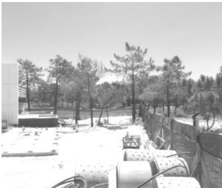
Figura 15: o jardim em construção
