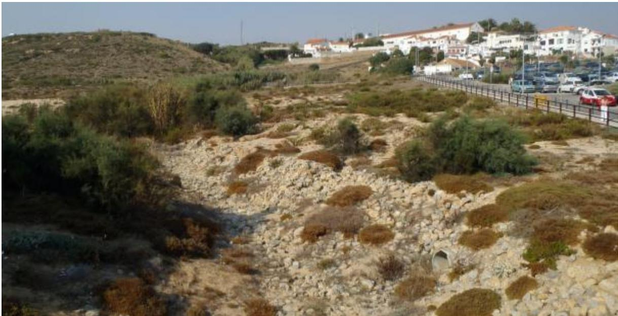
Figura 31– Vista actual da linha de água torrencial com o enrocamento e desenvolvimento do *Arundo donax* (Setembro 2012)
