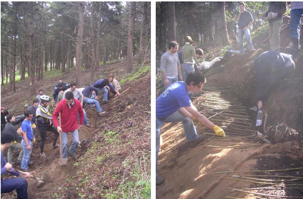
Figura 37 – Fase de abertura de degrau e aplicação de estacas
