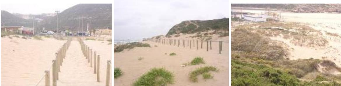
Figura 8 - Cobertura dos passadiços com areia pela acção do vento e ausência de vegetação na duna.
