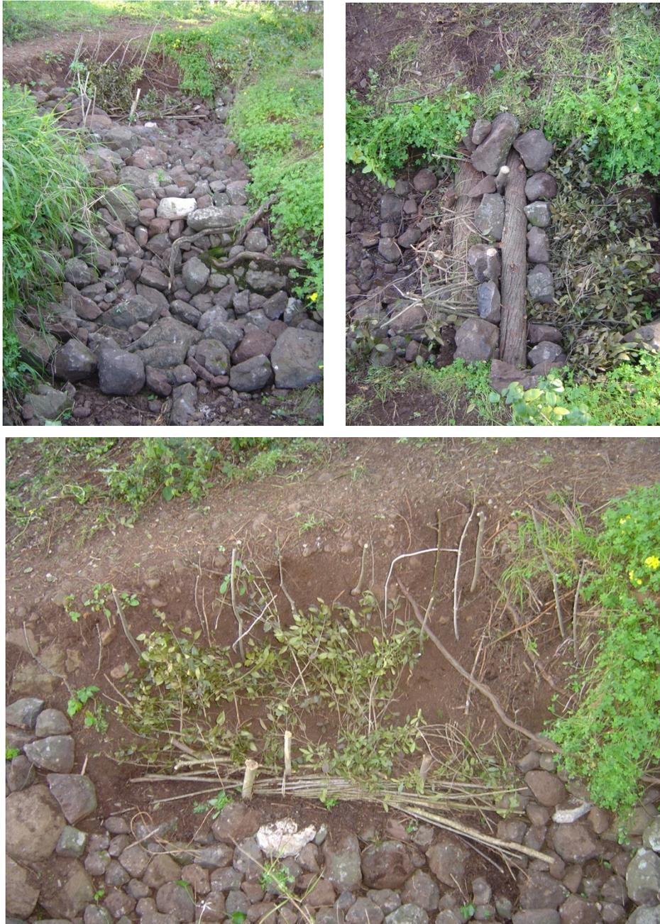
Figura 40 – Revestimento de leito, barragem de correcção torrencial e faxina viva
