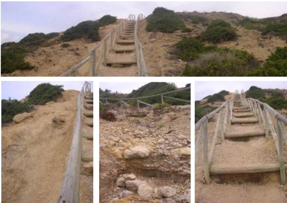
Figura 12 - Pormenores da escada e da acção erosiva na envolvente à mesma.
