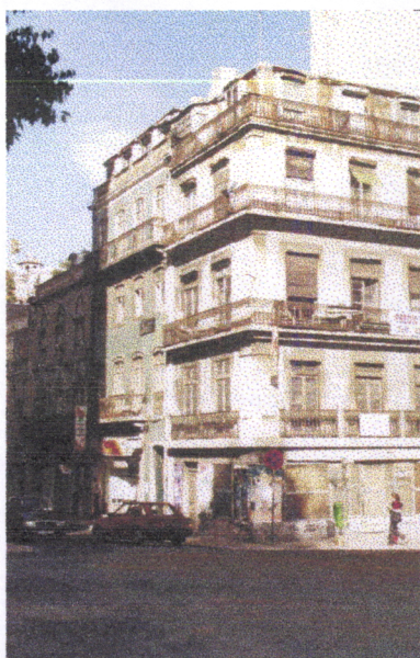
Fig. 141 Avenida da Liberdade, n.º 102 a 106 e Rua das Pretas, n.º 49.
