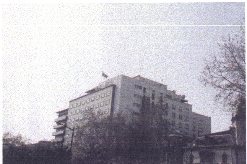
Fig. 132 O Hotel Tivoli, sito na Avenida da Liberdade, n.º 185 a 187.
