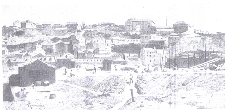
Fig. 5 As obras de construção da Avenida da Liberdade em 1882.
