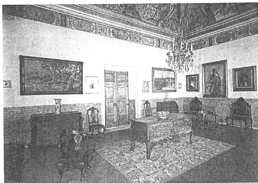
A mesma sala depois das obras de adaptação.
