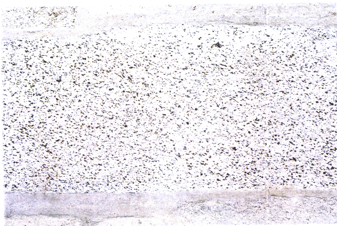
Fig. 8.5 – Igreja de S. Francisco de Évora. Quartzodiorito com a presença de biotite, em grande quantidade, alinhada no sentido perpendicular
