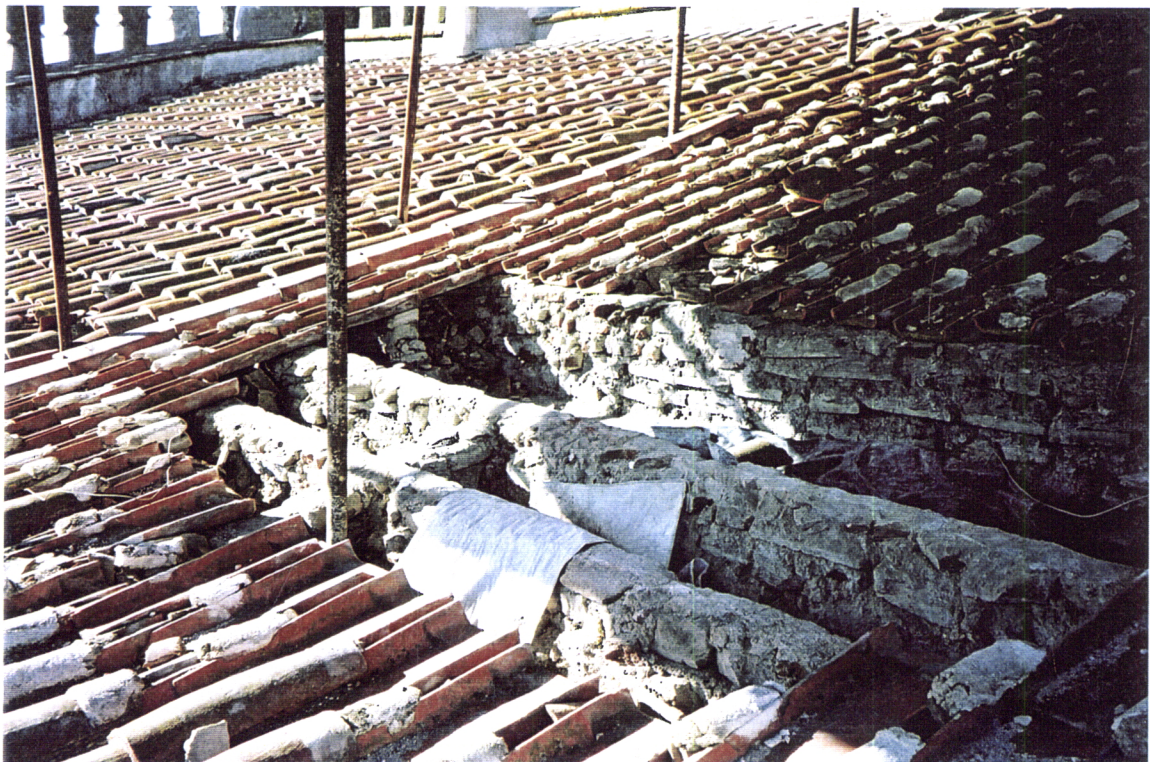
Fig. 8.13 – Igreja de S. Francisco de Évora. Muretes de alvenaria na estrutura do telhado da nave
