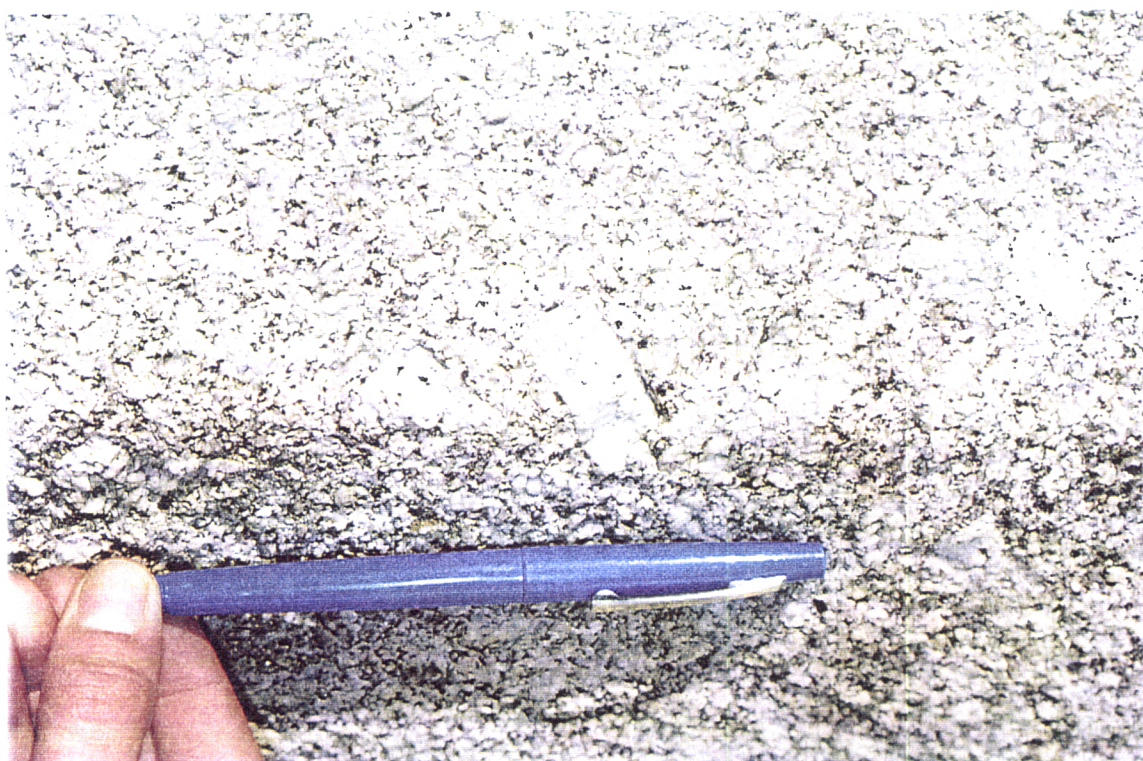
Fig. 8.6 – Igreja de S. Francisco de Évora. Granito porfiróide, de textura inequigranular, com a presença de feldspatos muito desenvolvidos
