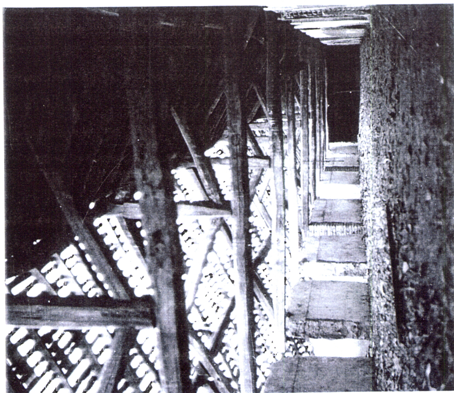
Fig. 8.14 – Igreja de S. Francisco de Évora. Interior do telhado da Capela dos Ossos
