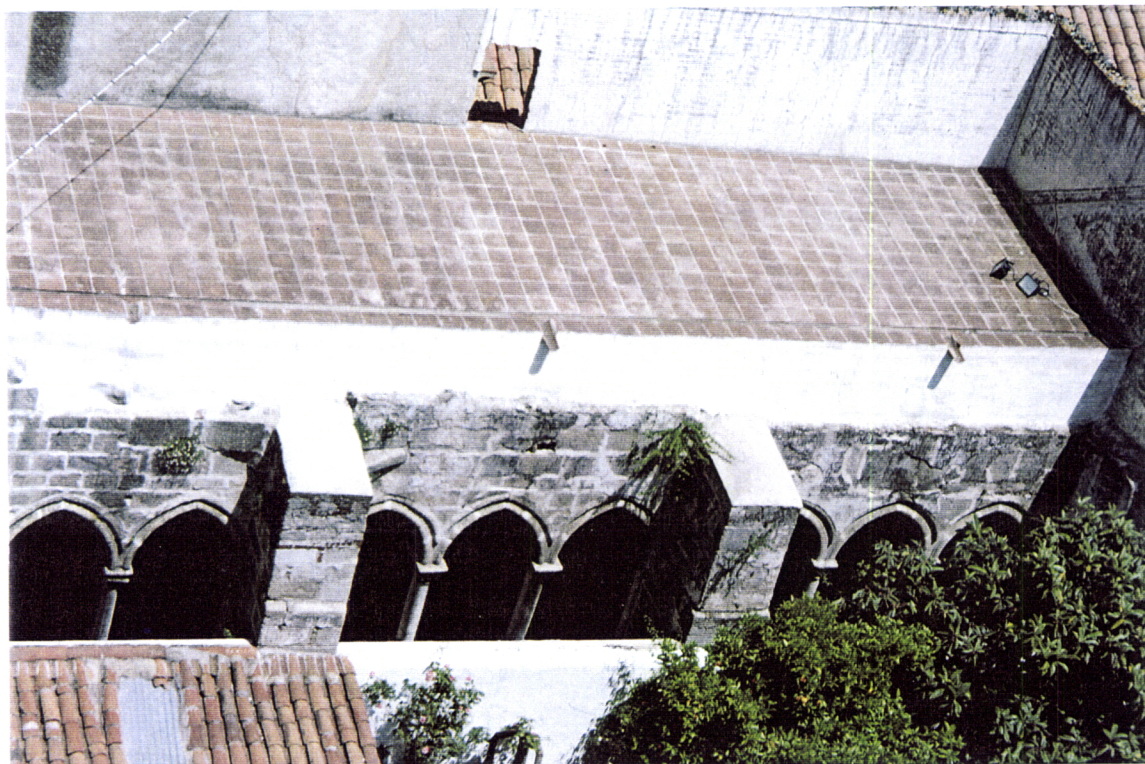
Fig. 4.31 – Igreja de S. Francisco de Évora. Cobertura em terraço da ala Nascente do claustro
