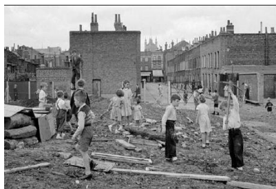
Fig. 198 Parque aventura construído numa área bombardeada onde as crianças dão nova vida aos destroços de guerra. Parque aventura Lollard . Londres, Inglaterra. (Kozlovsky, 2007)
