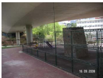
Fig. 284 EJR situado por baixo de um viaduto, marginal em relação aos espaços de sociabilização e em situação claramente inestética, degradada e inapropriada para o recreio. Rua Filipe da Mata, Lisboa. ( www.cm-lisboa.pt )
