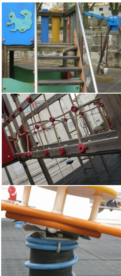
Fig. 194, 195 e 196 Riscos desnecessários: Mau estado dos equipamentos. Degrau partido. Cordas soltas. Equipamento desparafusado. (sanfins.blog.com) (www.viverlisboa.org/?p=7182) (www.viverlisboa.org/?p=7182)
