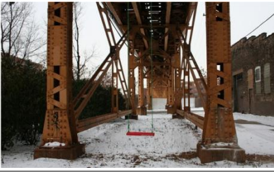
Fig. 225 Instalação de um balanço vermelho num lugar aparentemente inóspito. Bucktown. Chicago, EUA. ( http://redswingproject.org/ )
