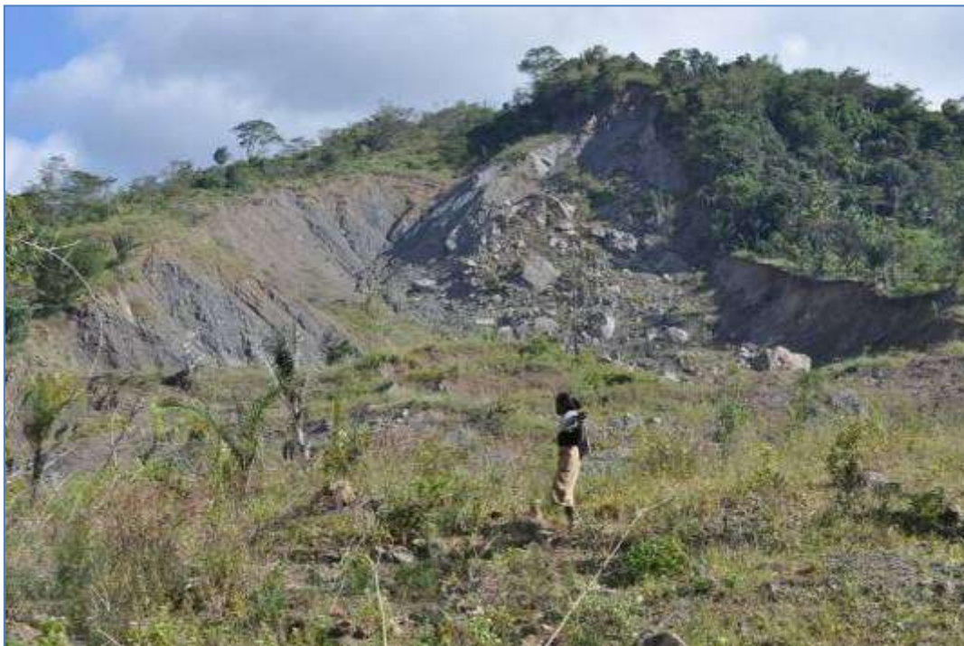
Figura 16. Escarpa principal do escorregamento Waisordaba Lacoliu Quelicai
