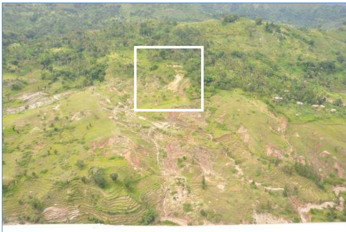
Figura.12a Deslizamento rotacional área de Baucau, Laga Waguia
