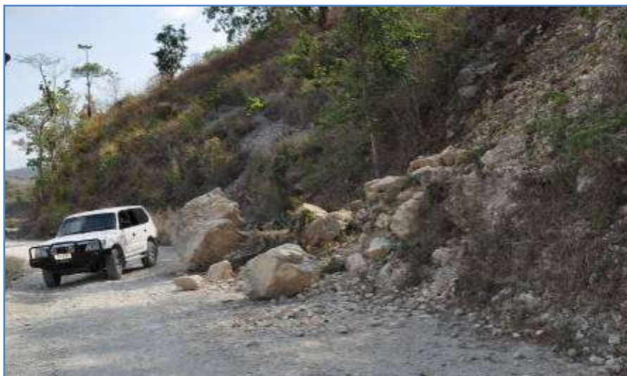
Figura 10a. Queda de blocos na área de trabalho Laga, Atelari
