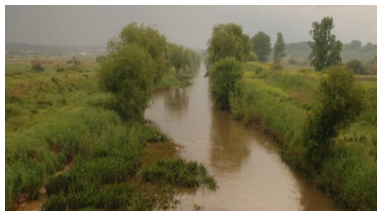
Figura 47 – Ponte de Miguel, montante.
