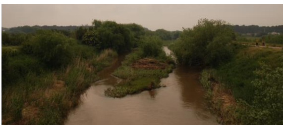
Figura 36 – Ponte da Junceira, jusante.
