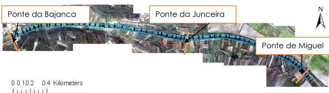
Figura 15 – Troço de 4 km do Rio Lis entre a ponte de Miguel e a ponte da Bajanca.
