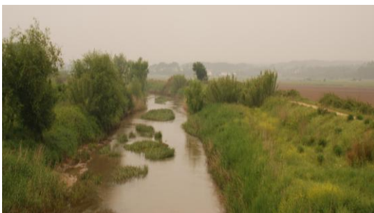
Figura 46 – Ponte de Miguel, jusante.
