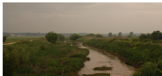
Figura 37 – Ponte da Junceira, montante.
