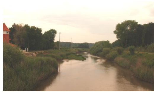
Figura 29 – Ponte da Bajanca, montante.
