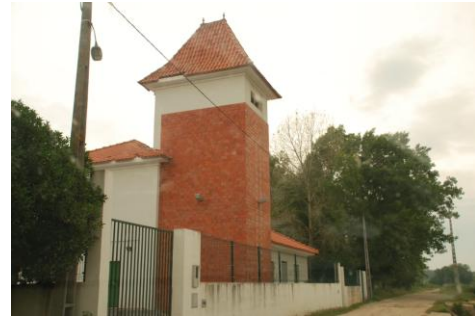
Figura 31 – Estação de bombagem.
