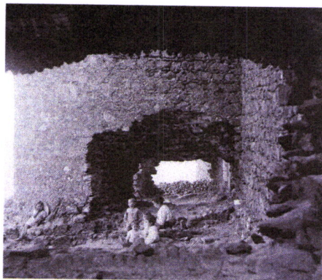
Fig. 6.7 – Avançado estado de degradação das torres e torreões da Cerca Medieval de Évora-Monte, 1942 (DGEMN/ DREMSul/ DM N.º IPA 0704040002, foto n.º 157766)
