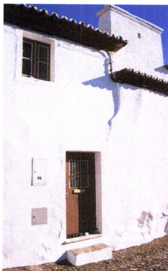
Fig. 4.41 - Casa tradicional com dois pisos no centro histórico de Évora-Monte (Foto da autora)
