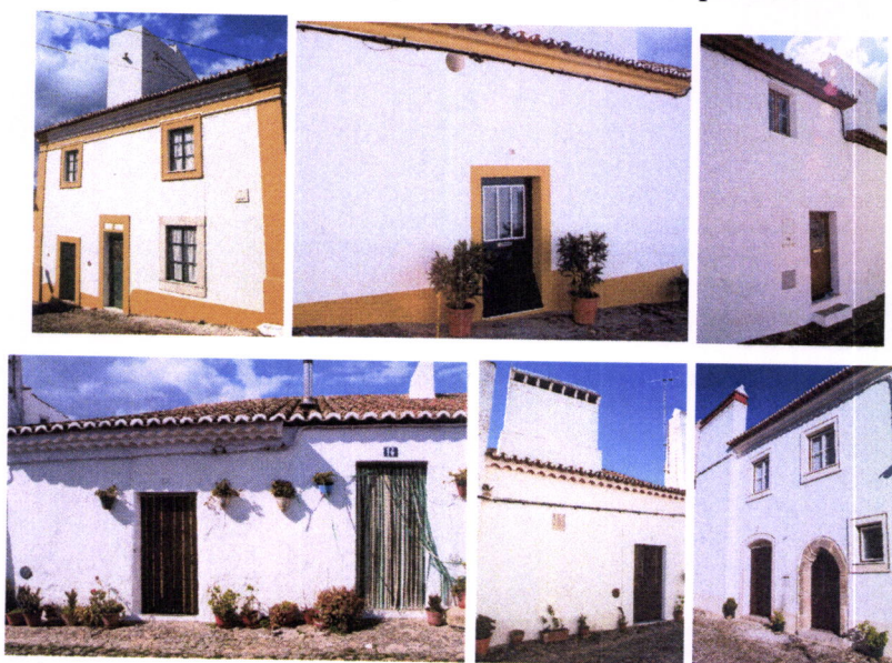
Fig. 5.34 – Paleta de cromatismos e texturas da Rua de Santa Maria no centro histórico de Évoramonte (Fotos da autora)
