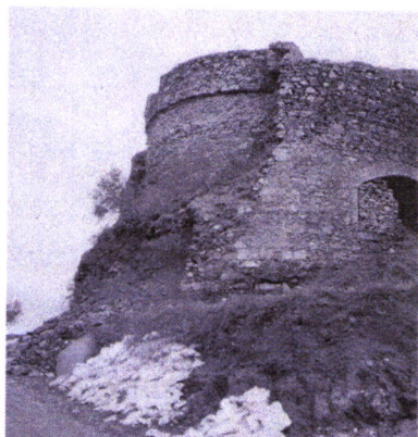
Fig. 6.8 – Reconstrução da parede externa do torreão nascente da Cerca Medieval, 1969 (DGEMN/ DREMSul/ DM N.º IPA 0704040002, foto n.º 157814)
