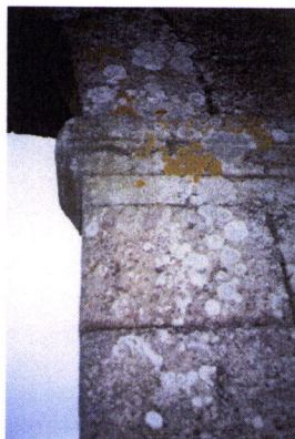
Fig. 4.60 – Colonizações microbiológicas na Porta do Sol da Cerca Medieval de Évora-Monte (Foto da autora)
