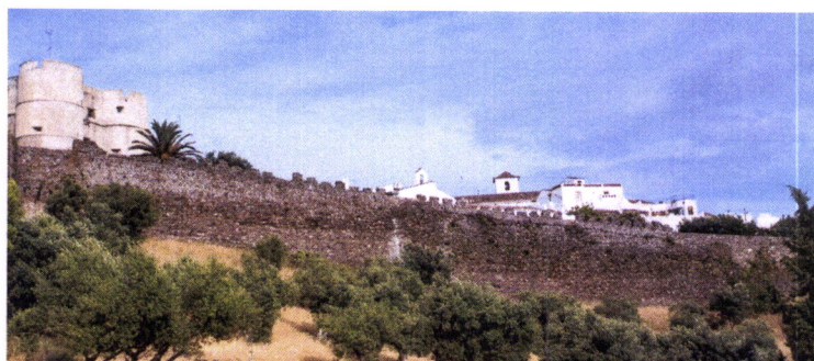
Fig. 4.63 – Pano da Cerca entre a Porta de São Sebastião e o Postigo na qual são visíveis o desaparecimento progressivo das ameias (Foto da autora)
