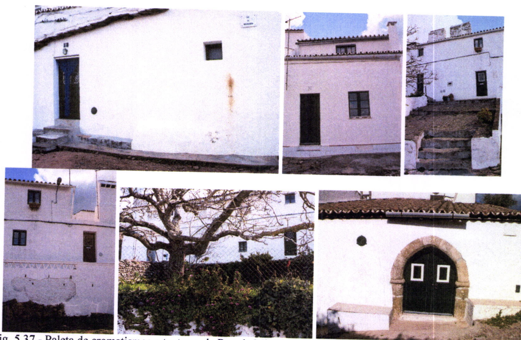
Fig. 5.37 - Paleta de cromatismos e texturas da Rua da Misericórdia no centro histórico de Évora-Monte (Fotos da autora)
