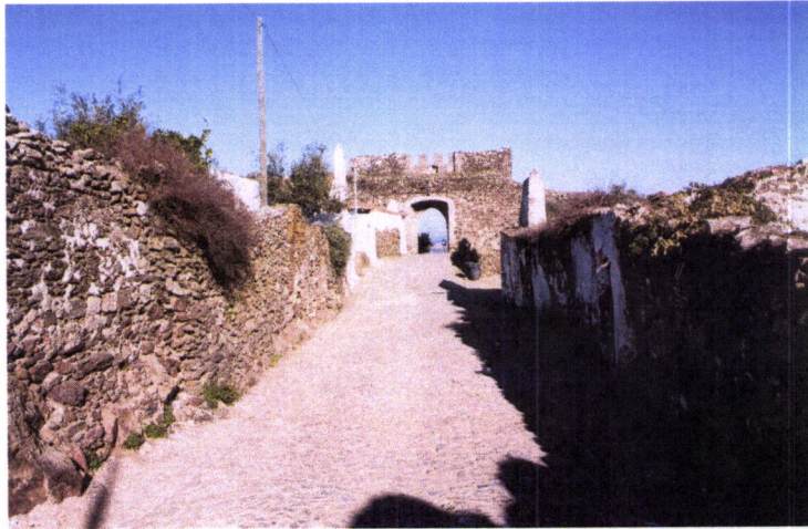
Fig. 5.31 – Nono ponto de vista do percurso pela «linha de força» do centro histórico de Évora-Monte, perspectiva fortemente marcada pelos muros dos quintais e edifícios em ruína (Foto da autora)
