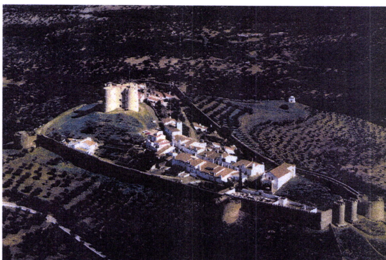
Fig. 2.1 – Vista aérea do centro histórico de Évora-Monte (Câmara Municipal de Estremoz)
