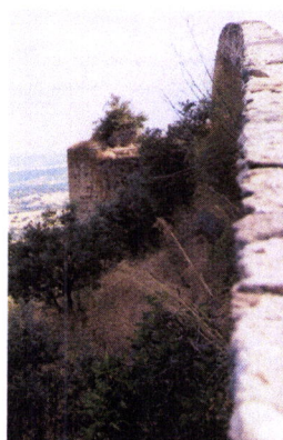
Fig. 4.60 – Colonizações microbiológicas na Porta do Sol da Cerca Medieval de Évora-Monte (Foto da autora)
