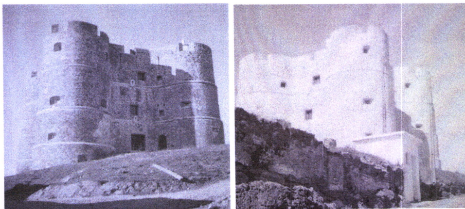
Fig. 6.10 – O Paço antes da reposição do reboco, 1975 (DGEMN/ DREMSul/ DM N.º IPA 0704040002, foto n.º 157829)
