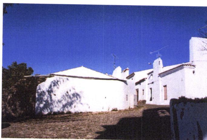
Fig. 5.25 - Terceiro ponto de vista do percurso pela «linha de força» do centro histórico de Évora-Monte, uma perspectiva cortada por um edifício-barreira (Foto da autora)
