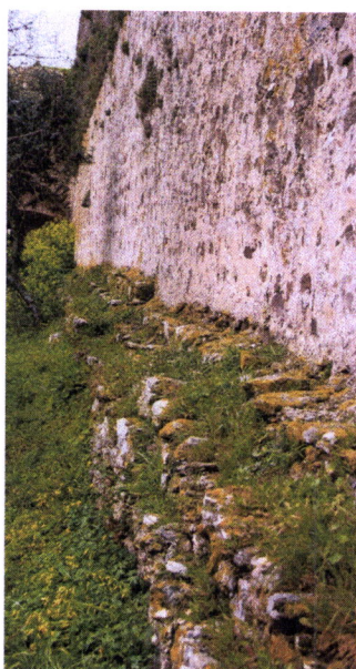
Fig. 4.45 – Pormenor das fundações em degrau da Cerca Medieval de Évora-Monte (Foto da autora)
