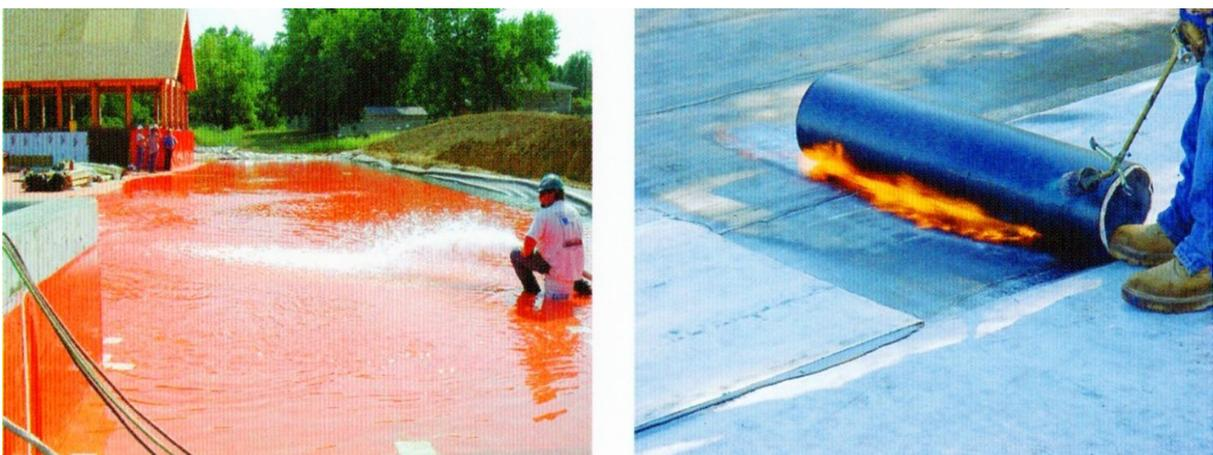
Fig. 56 – Membrana de impermeabilização em PVC (à esquerda) e membrana Betuminosa (à direita). Fonte: Earth Pledge, (2005).
