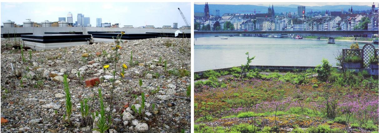
Fig. 50 e 51 – Exemplo de solo aplicado em Brown Roof (à esquerda) Desenvolvimento da vegetação num Brown Roof (à direita). Fonte: Earth Pledge, (2005).
