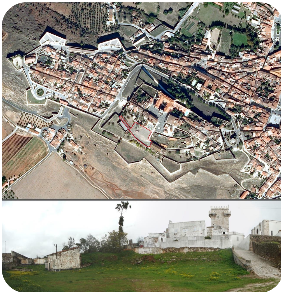
Figura 49 – Ortofotomapa com delimitação do espaço de intervenção e fotografia atual do espaço adjacente ao quartel
