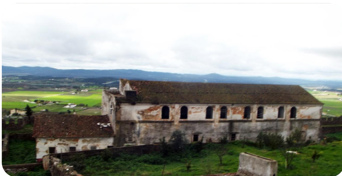
Figura 28 – Quartel no Interior do Castelo
