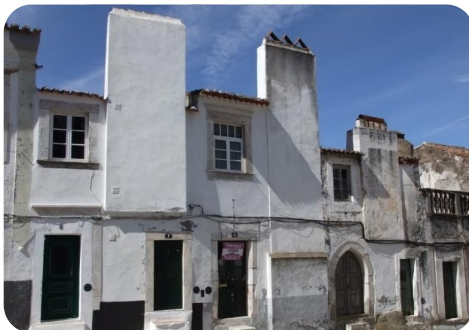
Figura 23 – Alçado das fachadas no Interior do Castelo
