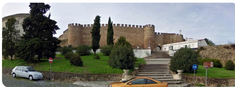
Figura 32 – Calçada da Frandina
