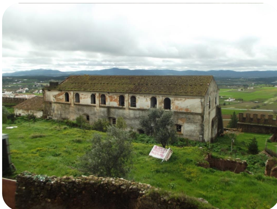
Figura 50 – Quartel que se pretende reabilitar
