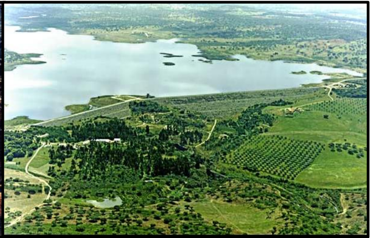
Figura 4. Barragem Monte da Rocha Fonte: http://cnpgb.inag.pt
