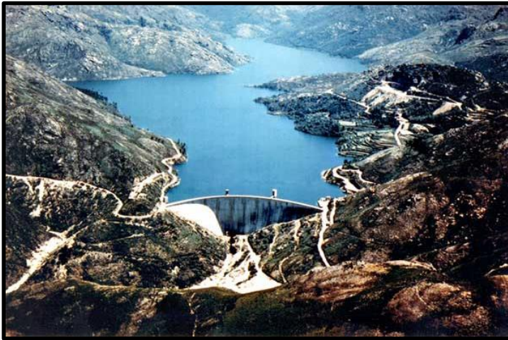
Figura 3. Barragem Vilarinho das Furnas Fonte: http://cnpgb.inag.pt
