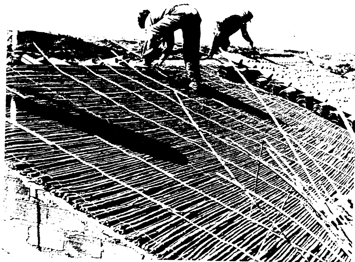
Fig. 4.367 – Processo de execução do forro de caniço (Ernesto Veiga de Oliveira, Fernando Galhano, Arquitectura Tradicional Portuguesa , 2ª Edição, Publicações D. Quixote, Lisboa, 1994, p. 163)
