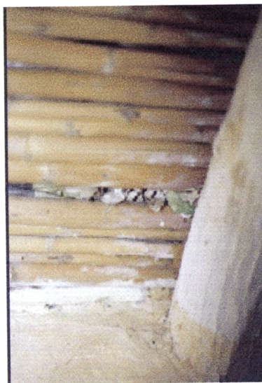
Fig. 4.368 – Moura, Bairro da Mouraria, colocação de isolamento entre a cobertura e o caniço (foto da autora)
