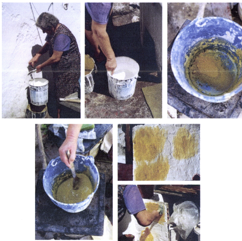
Fig. 4.404, Fig. 4.405 Fig. 4.406, 4.407 e Fig. 4.408 – Moura, Bairro da Mouraria, preparação da tinta para pintura a cal (fotos da autora)
