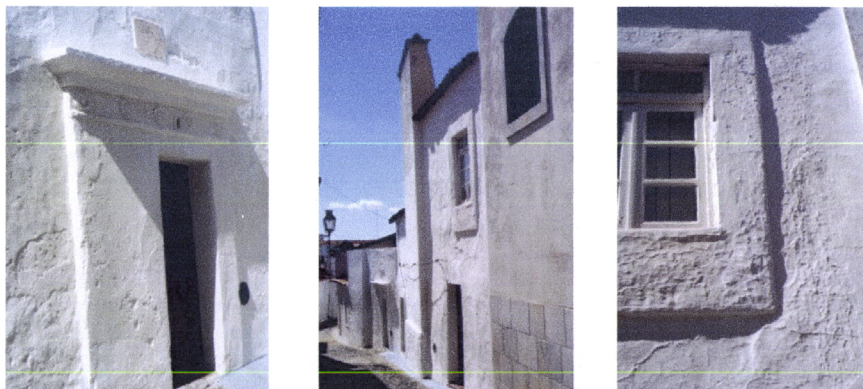
Fig. 4.346, Fig. 4.347 e Fig. 4.348 – Moura, Bairro da Mouraria, criação de texturas pelas caições sucessivas dos paramentos ( fotos da autora)
