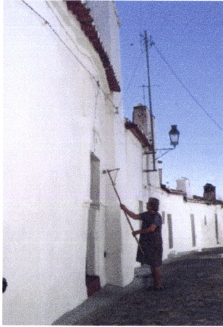
Fig. 4.343 e Fig. 4.344 - Moura, caição de uma das casas da 1ª Rua da Mouraria (fotos da autora)
