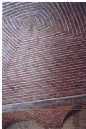
Fig. 4.291 - Moura, processo de execução da abobadilha (foto da autora)
