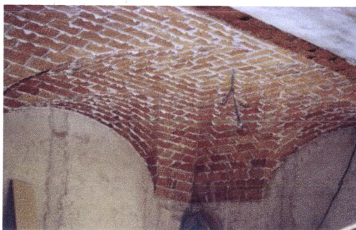
Fig. 4.291 - Moura, processo de execução da abobadilha (foto da autora)
