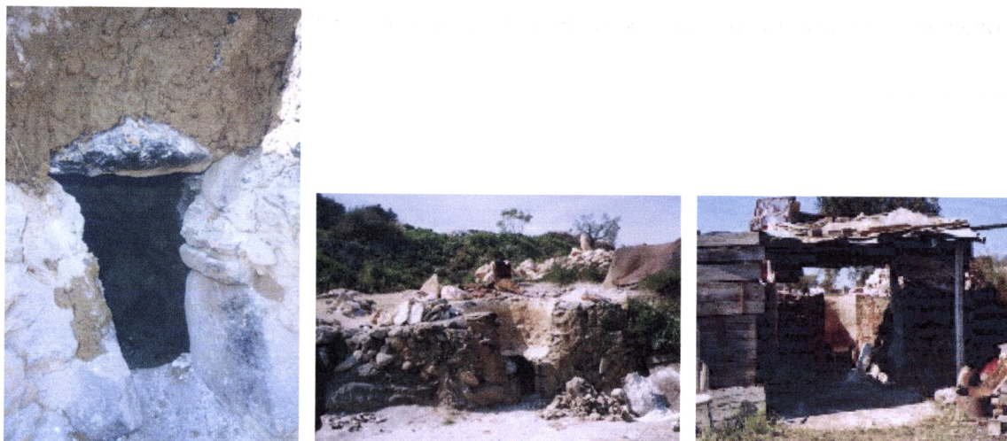
Fig. 4.314, Fig. 4.315 e Fig. 4.316 – Fornos de cal branca em funcionamento na área limítrofe de Moura (fotos da autora)
