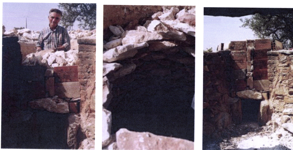
Fig. 4.323, Fig. 4.324 e Fig. 4.325 – Idem , colocação da pedra no forno (fotos da autora)
