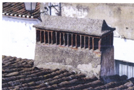
Fig. 4.308 – Moura, Bairro da Mouraria, uso da telha de canudo nos telhados (foto da autora)
