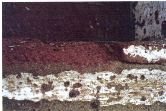
Fig. 4.310 - Moura, Bairro da Mouraria, tijolo em estado de degradação avançado (foto da autora)
