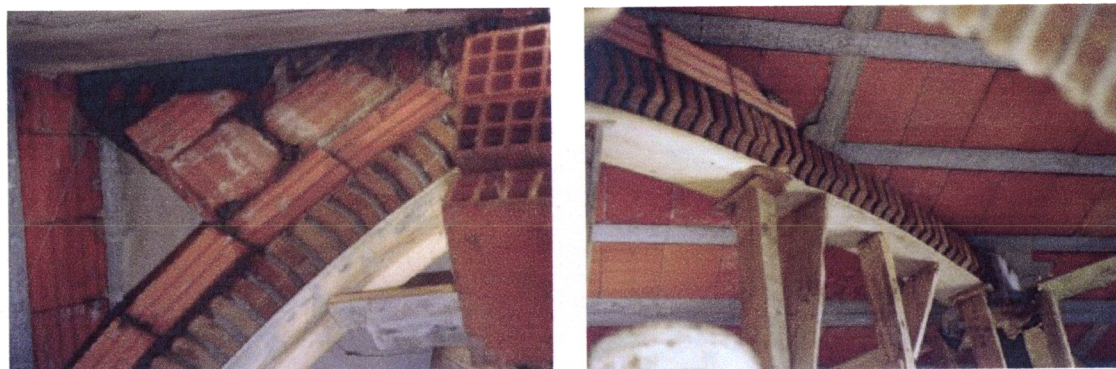
Fig. 4.289 e fig. 4.290 - Moura, processo de construção de uma abóbada ( fotos da autora)
