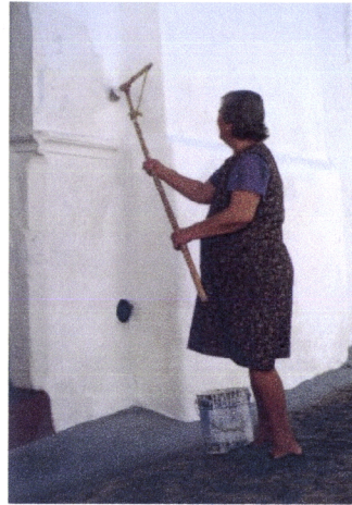
Fig. 4.343 e Fig. 4.344 - Moura, caição de uma das casas da 1ª Rua da Mouraria (fotos da autora)
