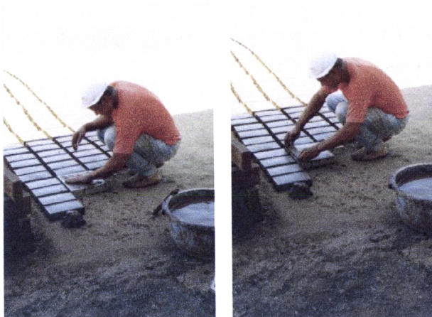
Fig. 4.281 – A massa é colocada no molde e é espalhada com a mão para preencher todo o molde (foto da autora)
