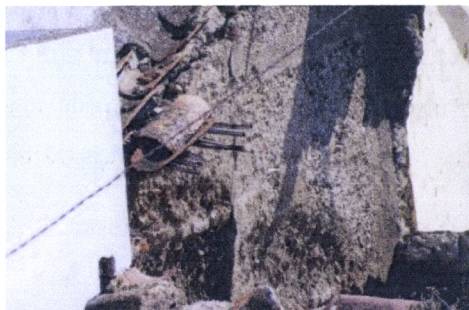
Fig. 4.276 – Moura, Bairro da Mouraria, utilização da taipa no levantamento de paramentos (foto da autora)
