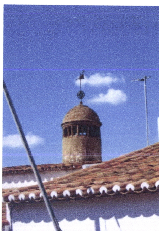
Fig. 4.308 – Moura, Bairro da Mouraria, uso da telha de canudo nos telhados (foto da autora)
