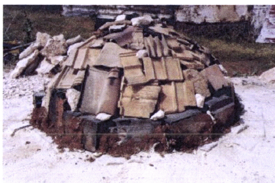
Fig. 4.327 – Idem , finalização da pedra no forno – fechamento da cúpula (foto da autora)
