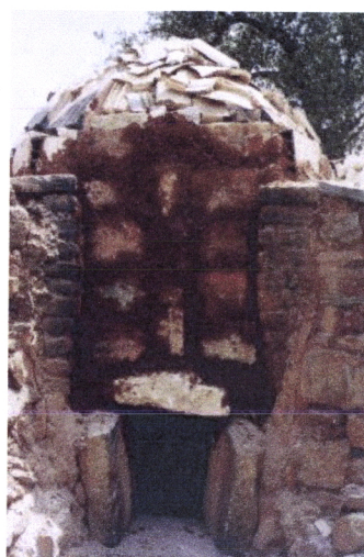
Fig. 4.326 – Idem , colocação da pedra no forno (foto da autora)
