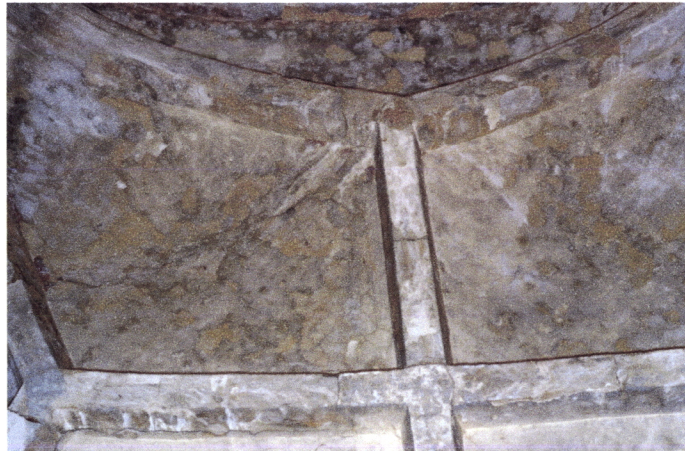
Fig. 4.102 – Moura, Convento de Nossa Sr.ª da Assunção do Castelo, abobada do compartimento (8) (foto da autora)
