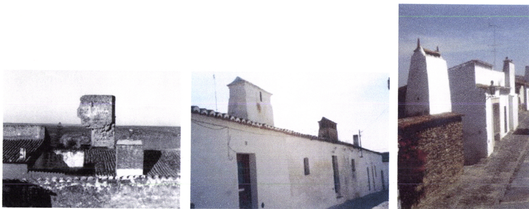
Fig. 4.132 – Moura, Bairro do Castelo, casa já desaparecida (BMM)
