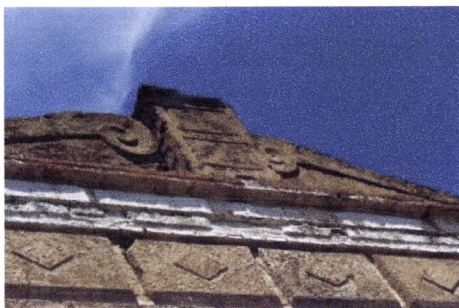
Fig. 4.173 e Fig. 174– Moura, Convento de Nossa Sr.ª da Assunção do Castelo, parede exterior da entrada principal, simulação de silharia (fotos da autora)
