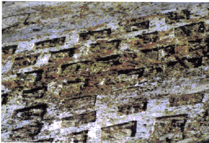
Fig. 4.162 e Fig. 4.163 - Moura, Castelo, Torre de Menagem, revestimentos e alvenaria em consecutiva degradação. (fotos da autora)
