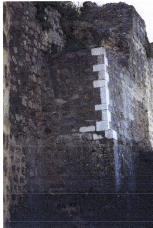
Fig. 4.160 - Castelo de Moura, muralha, local de extracção da amostra de revestimento para posteriormente ser analisada no LNEC (foto da autora)
