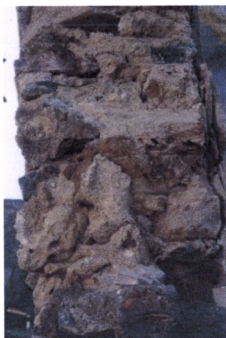
Fig. 4.147 – Moura, Castelo, Casa "medieval" do Castelo, parede em alvenaria de pedra irregular (foto da autora)
