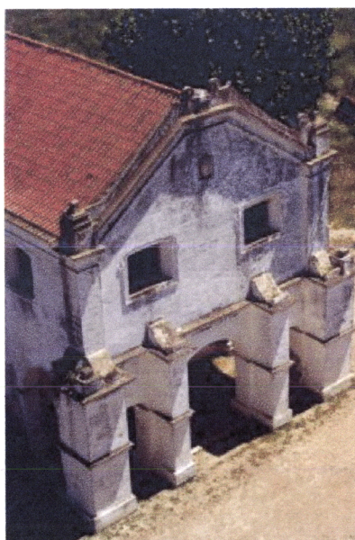
4.106 – Moura, Igreja de Sta. Maria do Castelo – cobertura (foto da autora)
