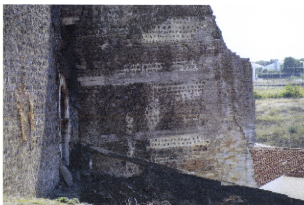
Fig. 4.156 e 4.157 - Moura, Castelo, restos da antiga fortificação, efeitos de claro-escuro conseguidos pelo contraste entre o revestimento e a alvenaria a descoberto, padrão circular e regular (fotos da autora)
