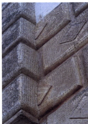
Fig. 4.173 e Fig. 174– Moura, Convento de Nossa Sr.ª da Assunção do Castelo, parede exterior da entrada principal, simulação de silharia (fotos da autora)
