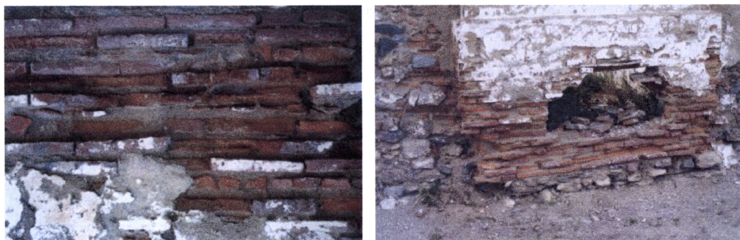
Fig. 4.145 e Fig. 4.146 – Moura, Castelo, casa "medieval" do Castelo, paredes em alvenaria de tijolo ( fotos da autora)
