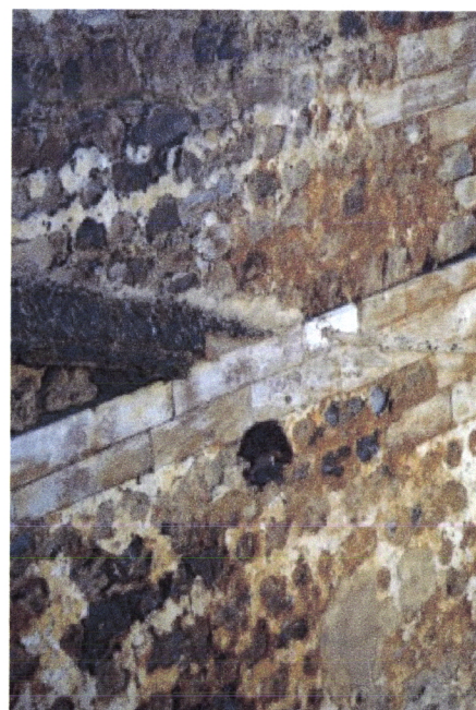
Fig. 4.162 e Fig. 4.163 - Moura, Castelo, Torre de Menagem, revestimentos e alvenaria em consecutiva degradação. (fotos da autora)
