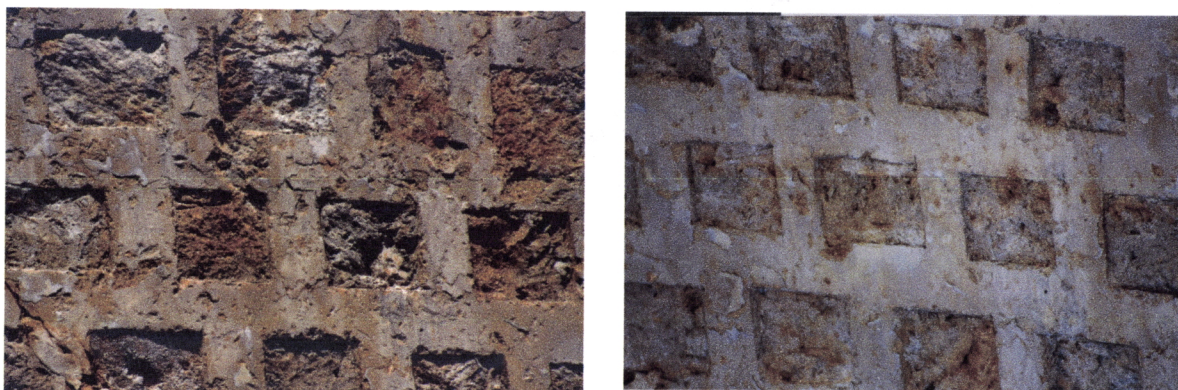
Fig. 4.152, Fig.4.153 - Moura, Castelo, Torre de Menagem, revestimentos aplicados como camadas sacrificiais (fotos da autora)
