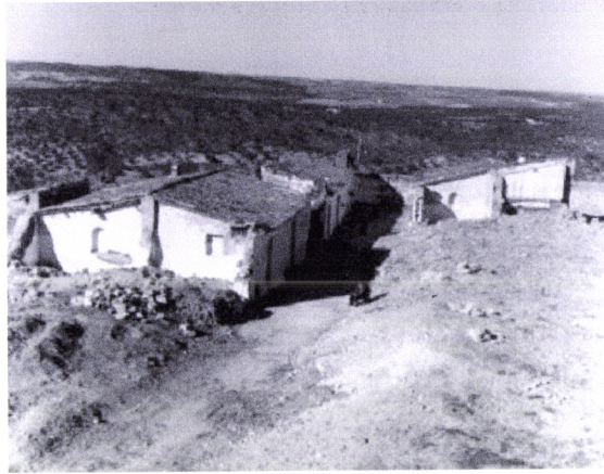
Fig. 4.124 – Moura, Bairro do Castelo, tipologia arquitectónica perpendicular à rua (BMM)
