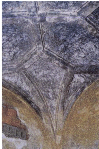
Fig. 4.101 – Moura, Convento de Nossa Sr.ª da Assunção do Castelo, abobada do compartimento (7) (foto da autora)
