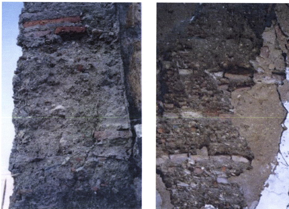
Fig. 4.143 e Fig. 4.144 – Moura, Castelo, casa "medieval" do Castelo, paredes em taipa (fotos da autora)
