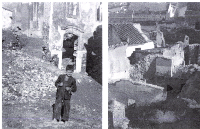
Fig.2.1 - Moura, demolição de parte do Convento de Nossa Sr.ª da Assunção do Castelo (Biblioteca Municipal de Moura)
