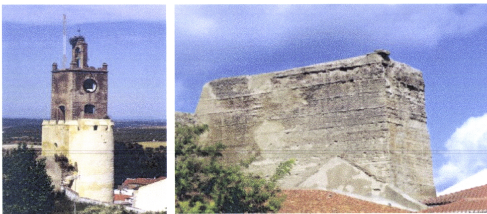
Fig. 2.13 – Moura, Castelo, Torre do Relógio, Fig. 2.14 – Idem , Torre em taipa (fotos da autora)
