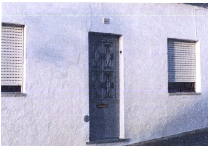
Fig. 2.15 - Moura, Bairro da Mouraria, deturpação da tipologia arquitectónica através da inserção de elementos não apropriados (foto da autora) Fig. 2.16 - Idem , integração de porta de alumínio e persiana no edifício (foto da autora)
