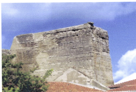
Fig. 4.2 – Moura, Castelo, torre em taipa (foto da autora) Fig. 4.3 - Idem, torreão arruinado em taipa (foto da autora)
