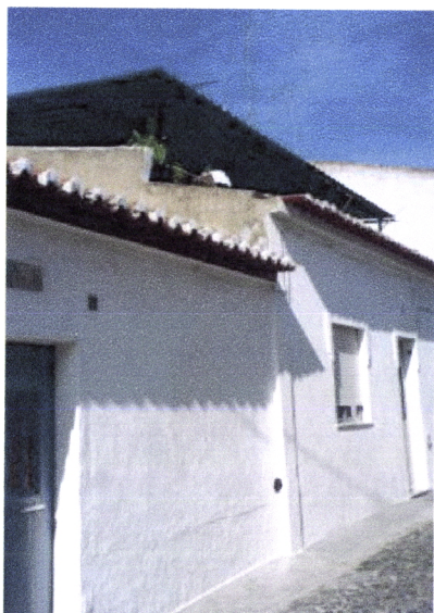
Fig. 2.15 - Moura, Bairro da Mouraria, deturpação da tipologia arquitectónica através da inserção de elementos não apropriados (foto da autora) Fig. 2.16 - Idem , integração de porta de alumínio e persiana no edifício (foto da autora)
