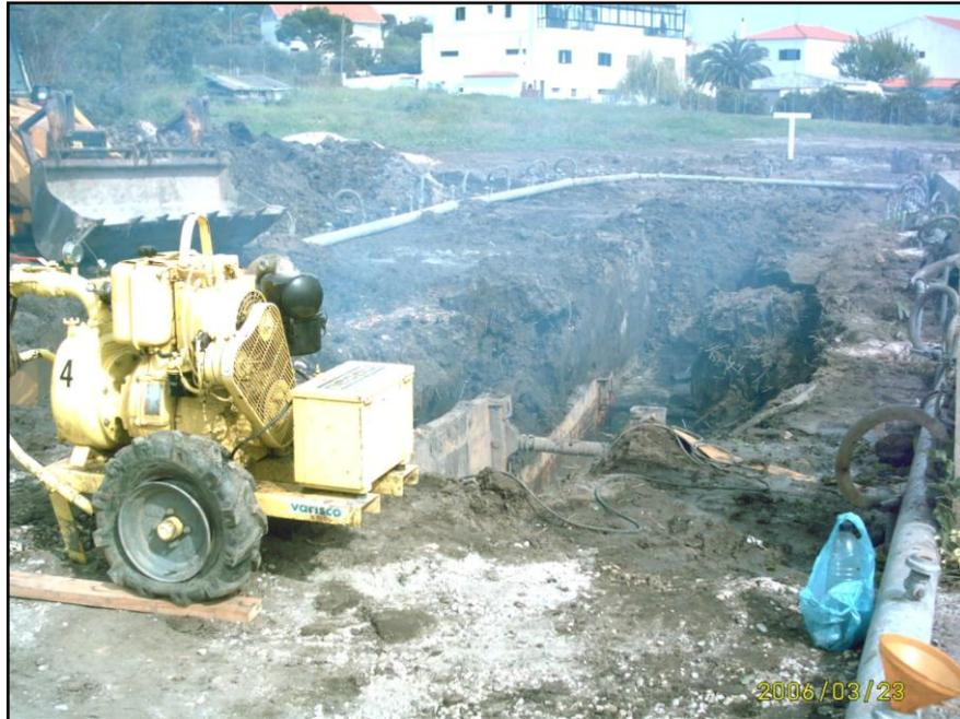
**Fotografia 1 – Drenagem de águas - agulhas filtrantes**
