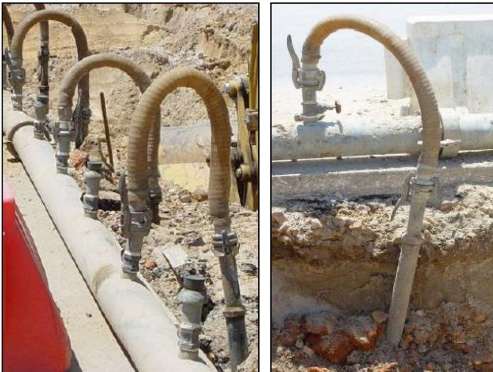
**Figura 12 – Drenagem por vácuo - Agulhas filtrantes (Miranda, s.d.)**
