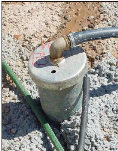
**Figura 15 – Bomba submersível - aspeto superficial** (Miranda, s.d.)
