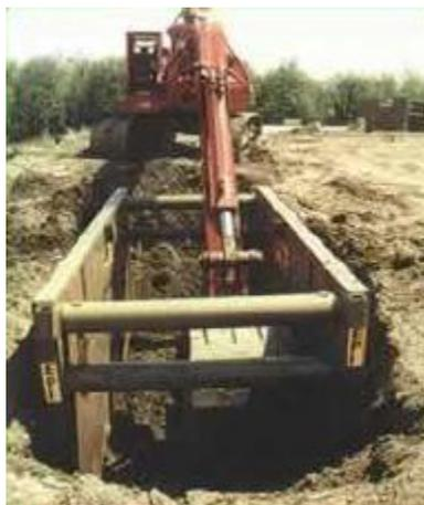
**Figura 23 – Escavação dentro dos painéis de entivação** (Manual de segurança, s.d.)
