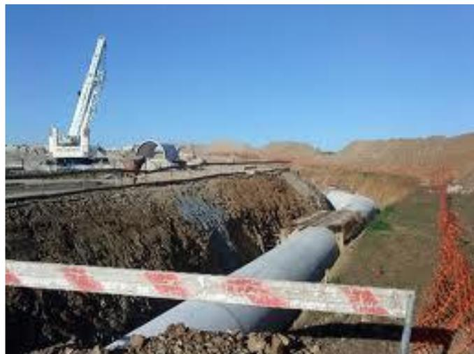
**Fotografia 3 – Sistema de Rega - Execução de troço de tubagem enterrada**
