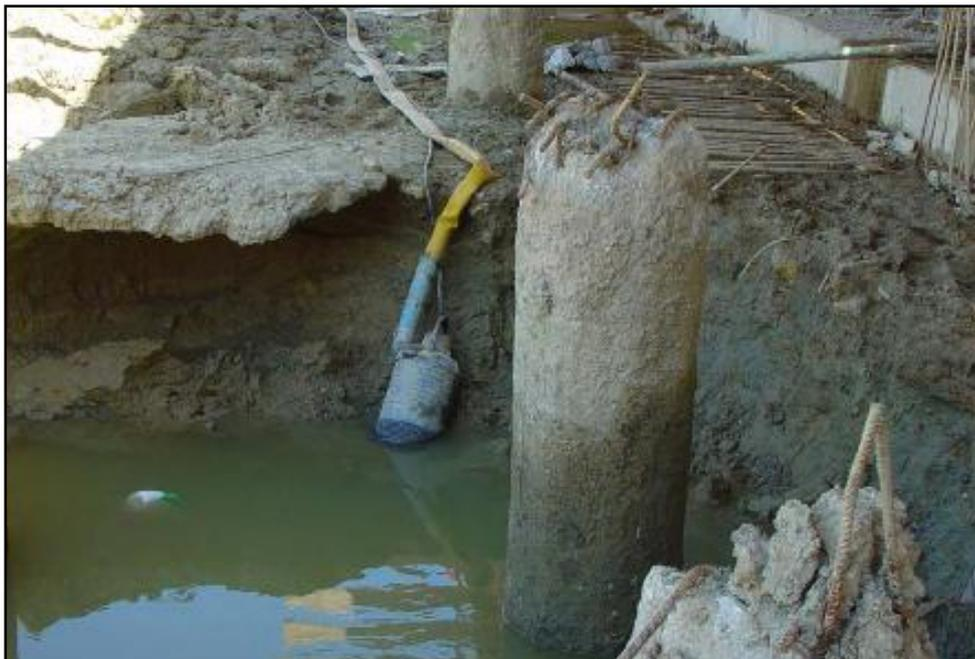
**Figura 14 – Poços de bombagem** (Miranda, s.d.)
