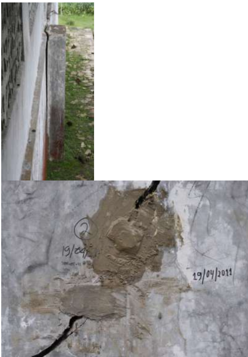
Fig: 6.2 Monitorização com o método de testemunho de cimento
