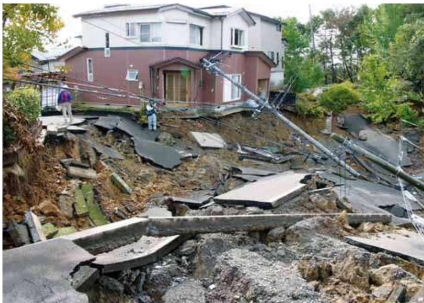
Fig: 3.15 Danos de deslizamento induzido por terremoto a uma casa construída sobre aterro artificial, após o terremoto de 2004, na Prefeitura de Niigata, Japão. (Fotografia pelo Professor Kamai, Universidade de Quioto, Japão).
