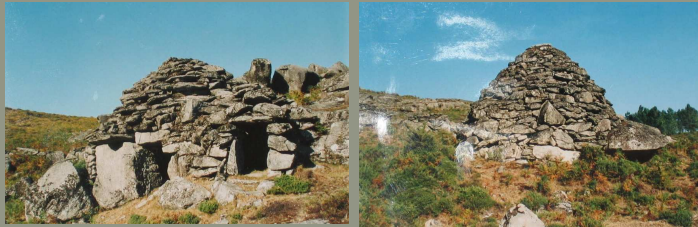
Branda ou abrigo localizada na Serra do Soajo
