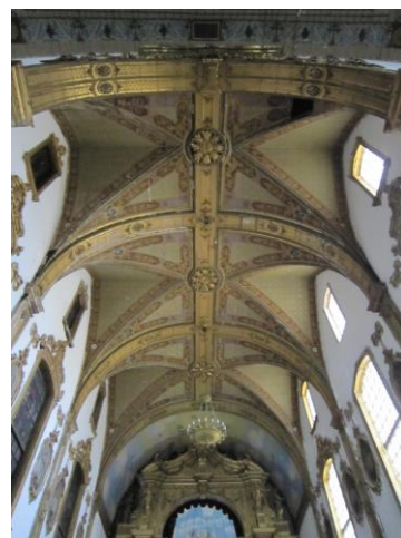
Figs. 37, 38 e 39 – Convento de Nossa Senhora do Carmo. Alçado principal da igreja, vista do interior e da abóbada de arestas quebradas da capela- mor.
