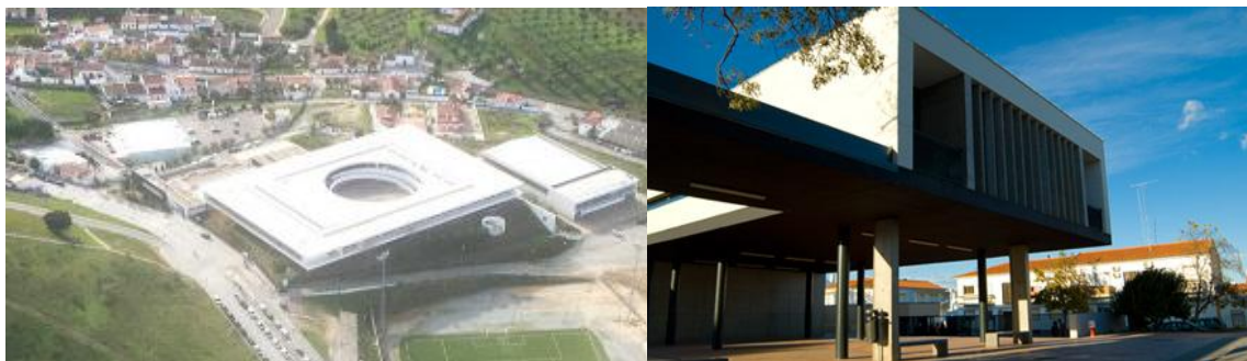
1 Edifício da EEBCR (à esquerda) e o edifício da ESGP (à direita).
