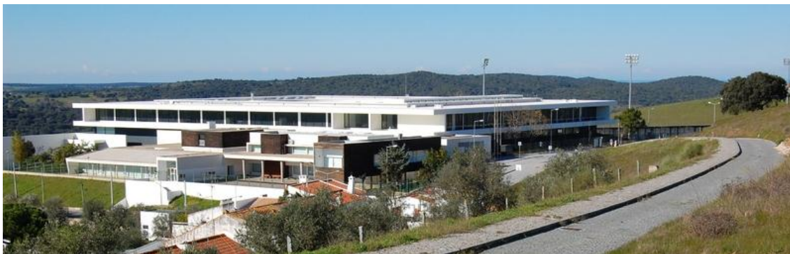
5 Vista da EEBCR – Sede do Agrupamento de Arraiolos
