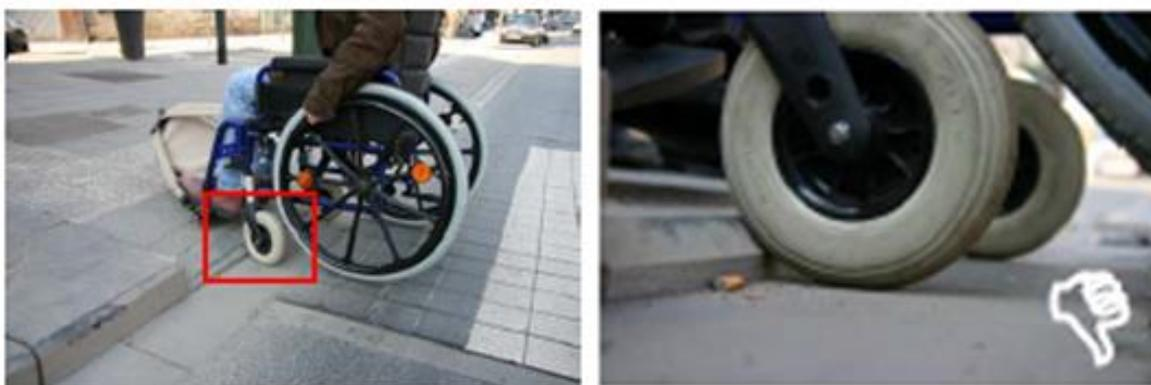
Figura 5.13: Exemplo de rebaixamento de lancil inadequado
