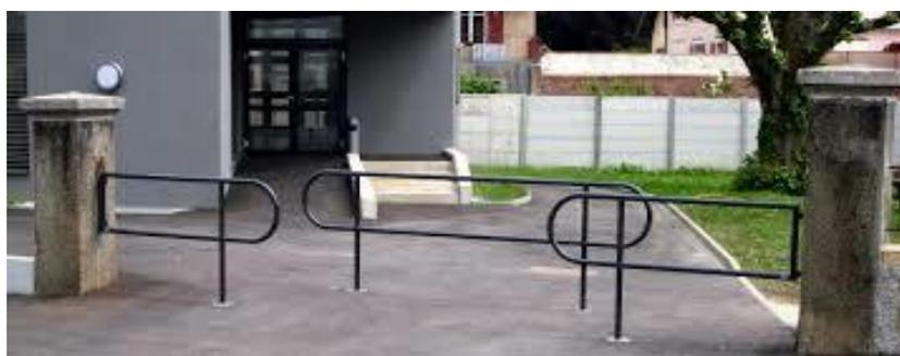
Figura 5.34: Exemplo de dispositivo de passagem seletivo utilizado na via pública
