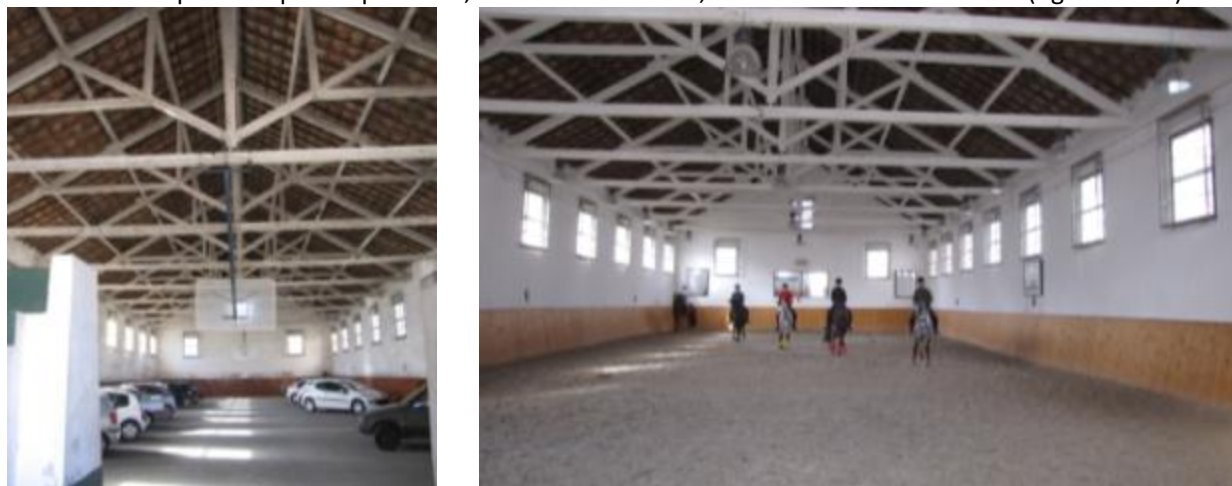
Figuras 6 e 7: Picadeiro. À esquerda: antes da intervenção; à direita: após a intervenção.
