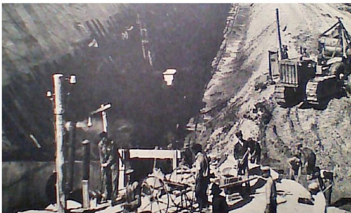
Construção Barragem do vale do Sado in 15 Anos de Obras Publicas, 1932-1947, 1º vol livro de Ouro, Lisboa, 1948, p. s/n, Arq particular ACM.
