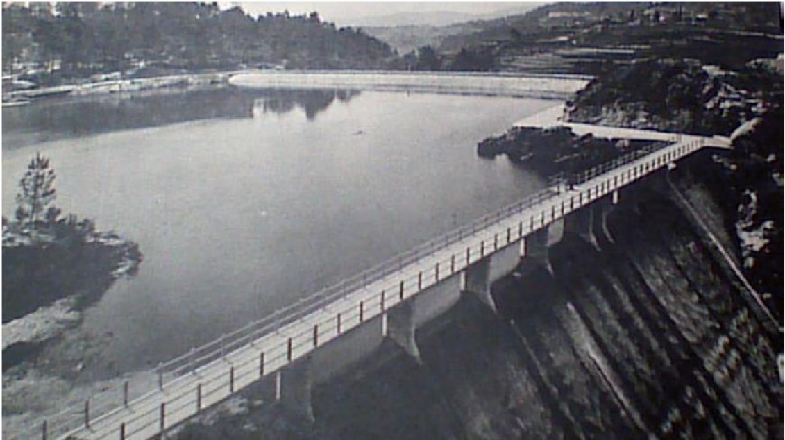
Albufeira da Barragem Duarte Pacheco in 15 Anos de Obras Publicas, 1932-1947 , 1º vol livro de Ouro, Lisboa, 1948, p. s/n. Arq particular ACM.
