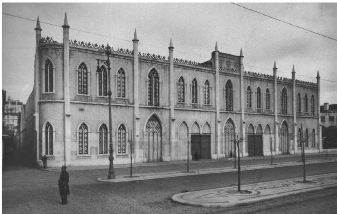
Fábrica de Gás da Companhia Lisbonense de Iluminação a Gás situada na Av 24 de Julho, em Lisboa (Hoje desaparecida), Fundação EDP- Museu da Electricidade,
