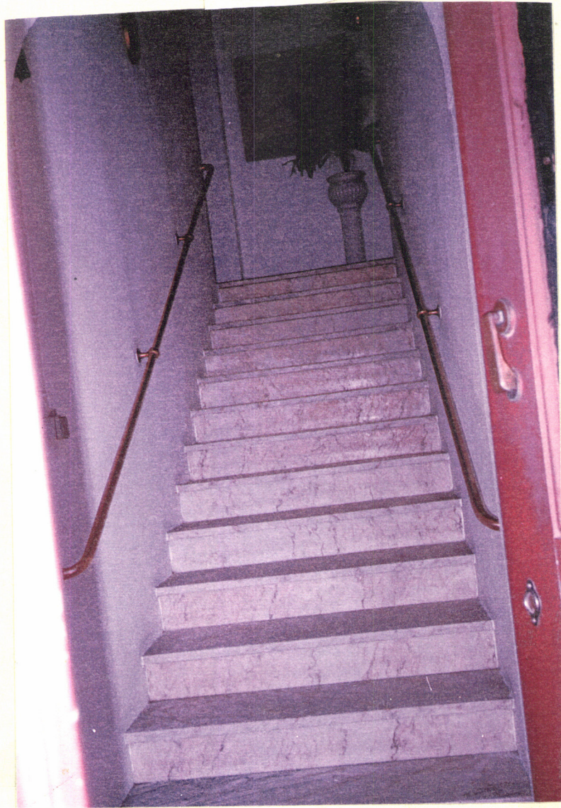
Zona A-Escadas de acesso ao Alojamento feminino
