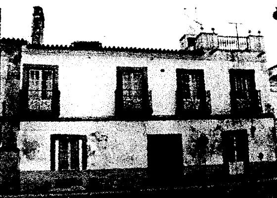
2.3.7.2.44- L. Portas do Sol, 5. Montemor
