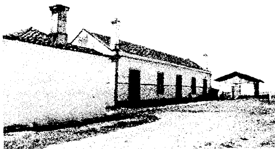
2.3.7.6.6- Estação caminho de ferro. Viana
