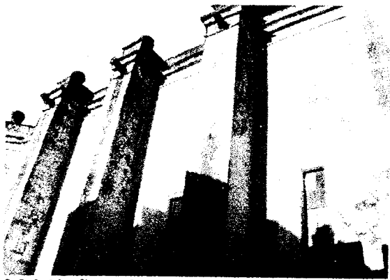
2.3.3.19- Contrafortes. Espirito Santo. Montemor
