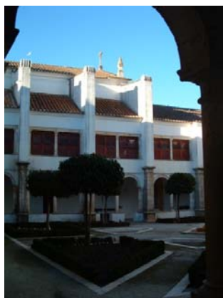
Figura 131 ■ Claustro. Vista geral.
