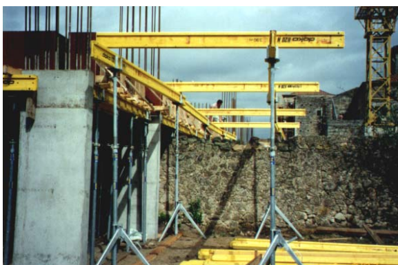
Figura 101 ■ Construção da ala nova.
