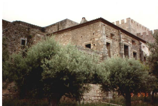
Figura 94 ■ Edifício pré-existente. Vista Oeste.
