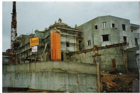
Figura 167 ■ Construção nova / mosteiro.
