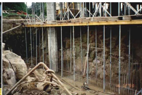
Figura 102 ■ Construção da ala nova.
