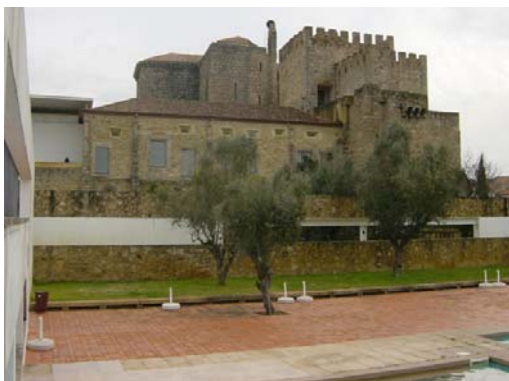
Figura 103 ■ Conjunto: vista da piscina / jardim.
