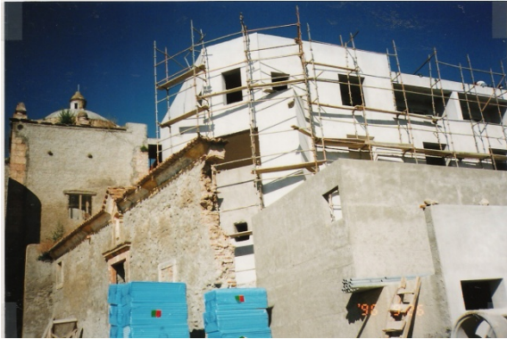
Figura 166 ■ Construção nova / mosteiro.
