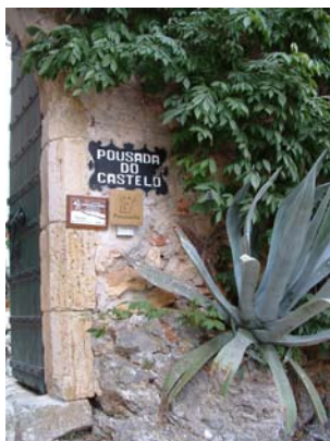
Figura 9 ■ Entrada da pousada (vista Sul).
