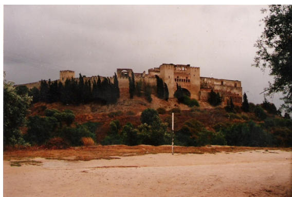
Figura 151 ■ Vista de conjunto.
