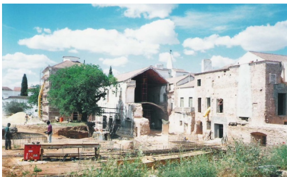
Figura 123 ■ Vista exterior (lado poente) e Torreão Norte.
