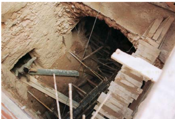
Figura 62 ■ Construção do túnel que liga o edifício novo e o pré-existente.
