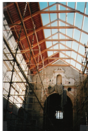
Figura 175 ■ Estrutura da cobertura da Igreja.
