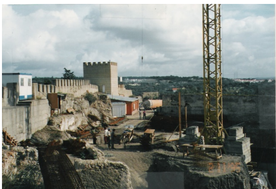
Figura 160 ■ Vista geral da obra.
