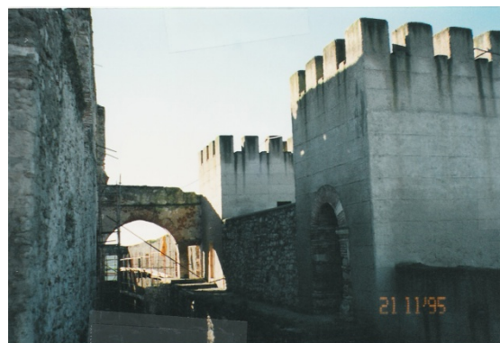
Figura 161 ■ Castelo e mosteiro: obra.
