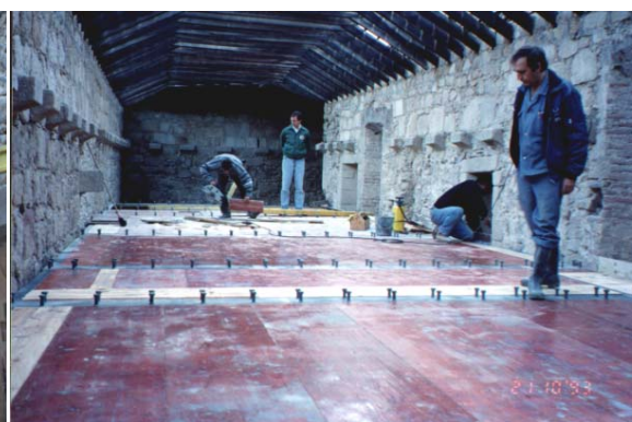
Figura 100 ■ Piso intermédio (construção de dois quartos): colocação de pavimento.
