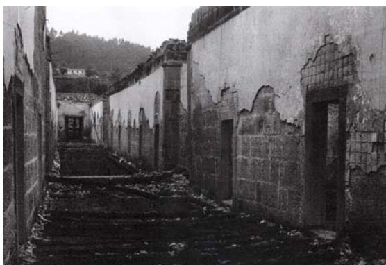
Figura 31 ■ Mosteiro em ruína.
