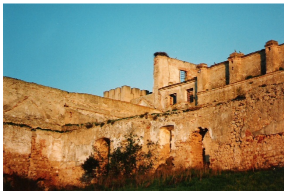
Figura 153 ■ Mosteiro em ruína.
