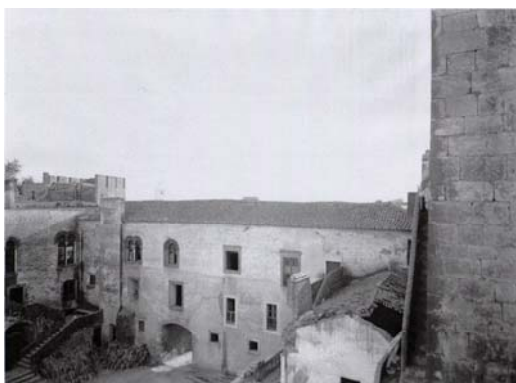
Figura 60 ■ Pátio e Paço (vista Oeste).
