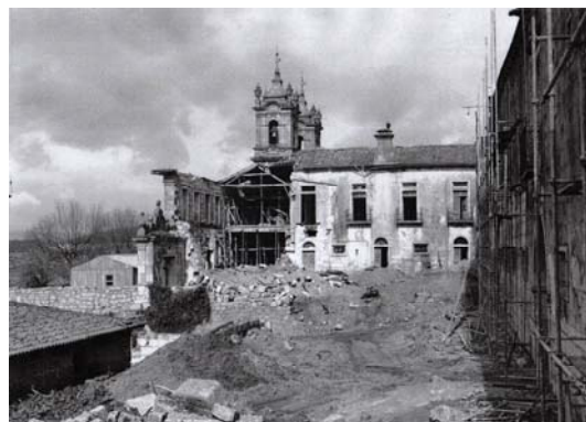
Figura 34 ■ Aspecto geral das obras da fachada.
