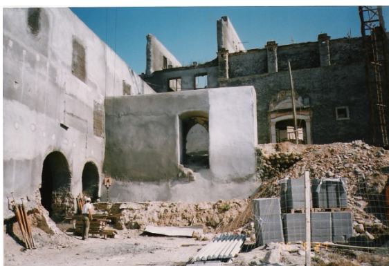
Figura 164 ■ Construção nova / mosteiro.
