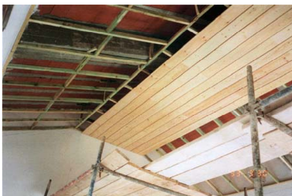
Figura 64 ■ Ala Oeste. Cobertura do interior do Paço.
