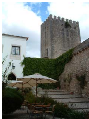
Figura 10 ■ Recinto e Torre D. Fernando (vista Este).
