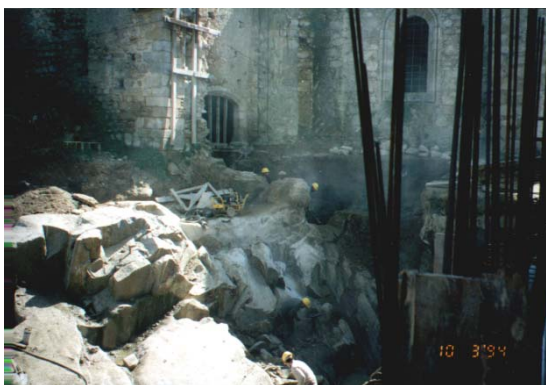
Figura 97 ■ Escavação para construção do elevador.
