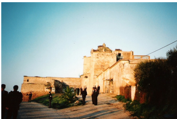
Figura 152 ■ Mosteiro em ruína.
