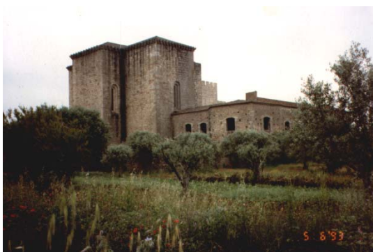
Figura 95 ■ Conjunto. Vista Este.
