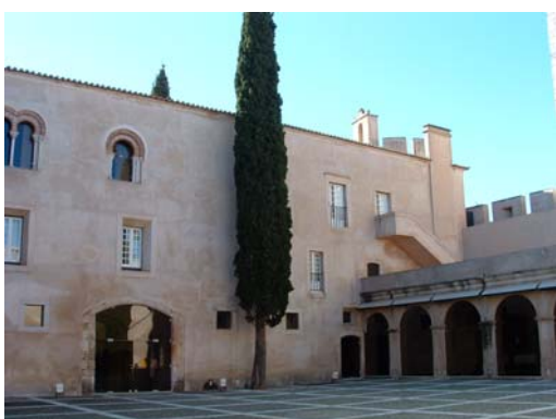
Figura 68 ■ Ala Oeste e Norte. Pátio.
