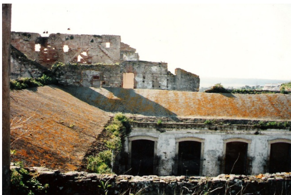
Figura 154 ■ Mosteiro e cobertura do claustro.
