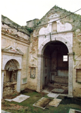
Figura 156 ■ Igreja em ruína.
