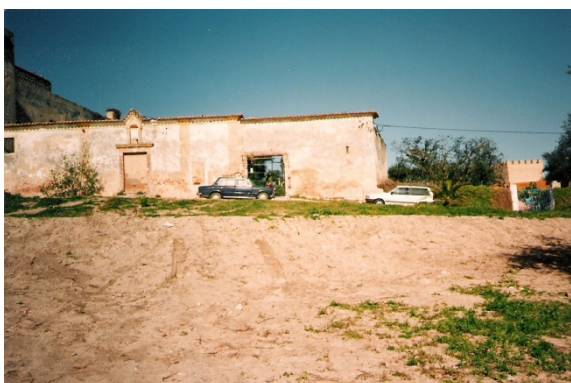
Figura 150 ■ Edifício em ruína.
