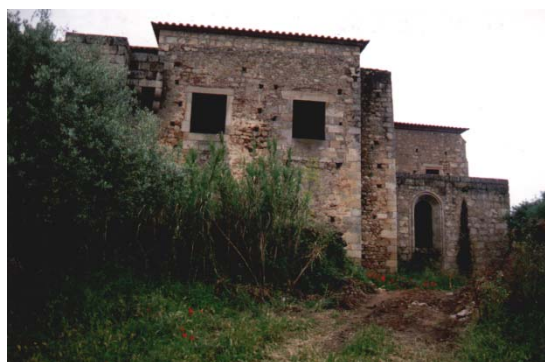
Figura 96 ■ Edifício pré-existente. Vista Norte.
