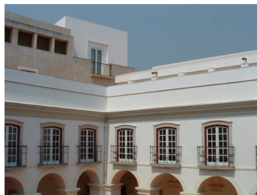
Figura 194 ■ Claustro: pisos 2 e 3.
