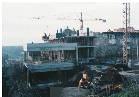
Figura 163 ■ Construção nova / mosteiro.
