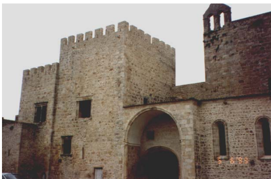
Figura 93 ■ Edifício pré-existente. Fachada principal.
