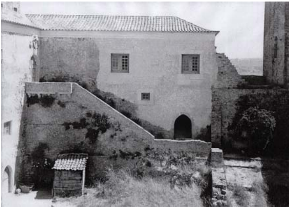
Figura 7 ■ Acesso ao interior do Paço (vista Este).
