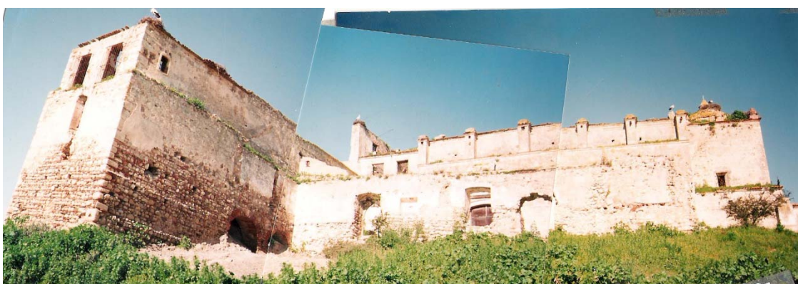
Figura 159 ■ Vista de conjunto.
