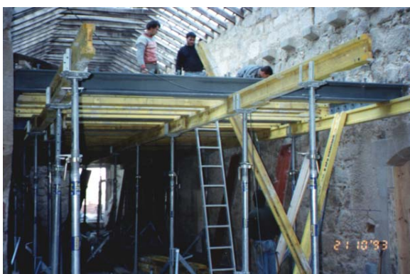
Figura 99 ■ Piso intermédio (construção de dois quartos): estrutura.
