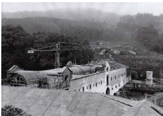
Figura 33 ■ Vista geral das obras.
