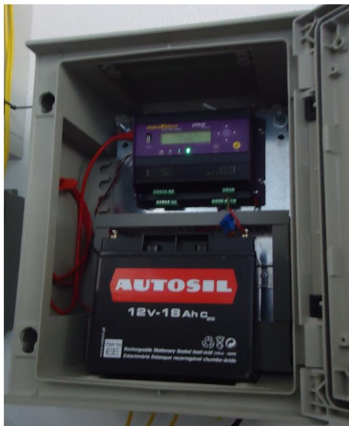
Figura 21 - Sistema de aquisição de dados da estação meteorológica de Portalegre.
