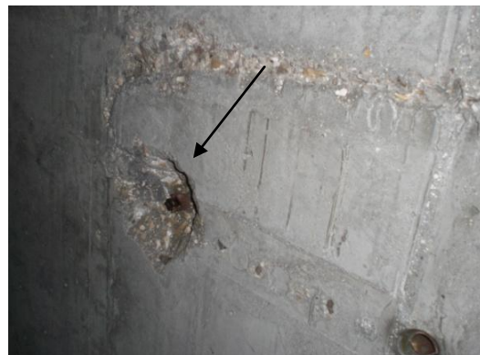
Figura 5.7 Pontas de aço usadas para manter a distância entre taipais de cofragem
