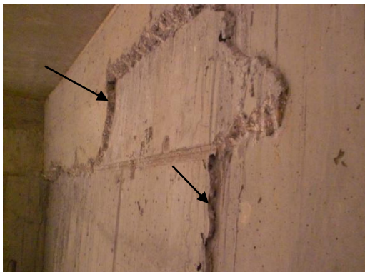
Figura 5.6 Descontinuidade entre elementos verticais consecutivos
