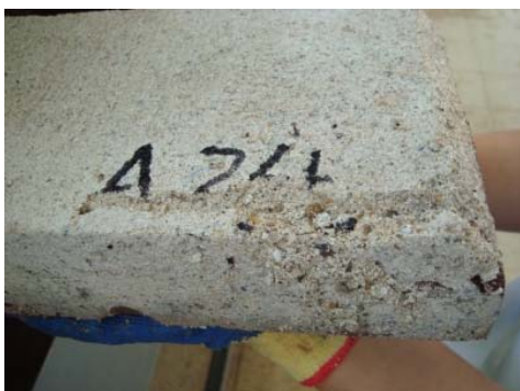
Figura 46: Início da degradação da argamassa A na 4ª repetição do 2º ciclo
