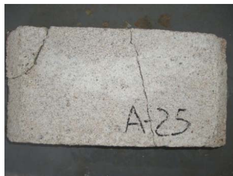
Figura 47: Início da degradação da argamassa A na 7ª repetição do 2º ciclo
