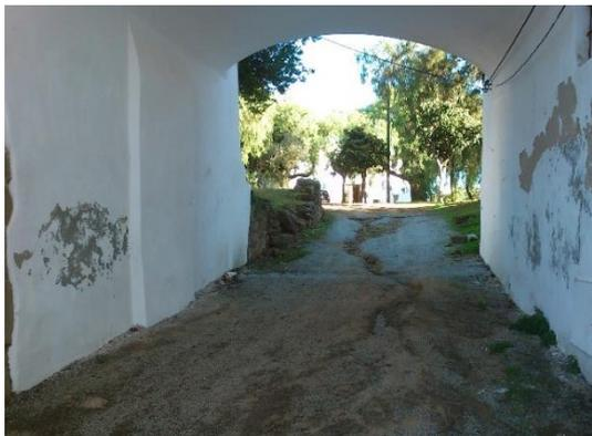
Fig. 15 - Ravinamentos causados pela erosão hídrica - Entrada Terreiro de S. Tiago
