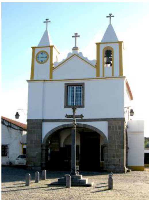
Fig. 2 Exterior da Igreja Paroquial de S. Manços (Évora).
