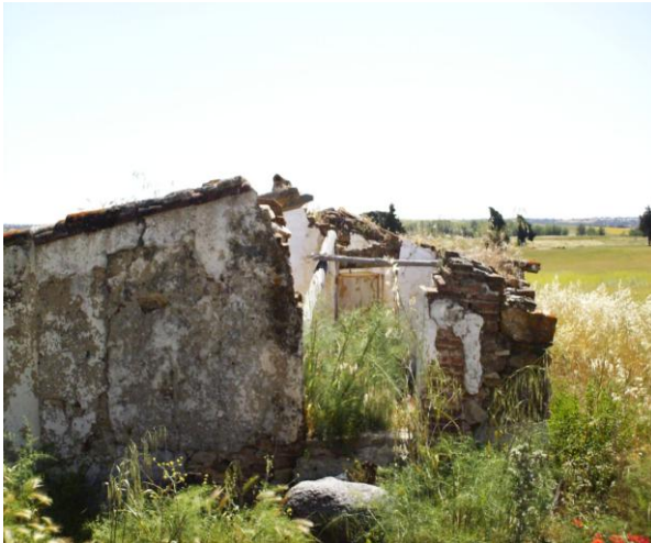
Fig. 34 Ruínas de habitações anexas ao Moinho de Vento.
