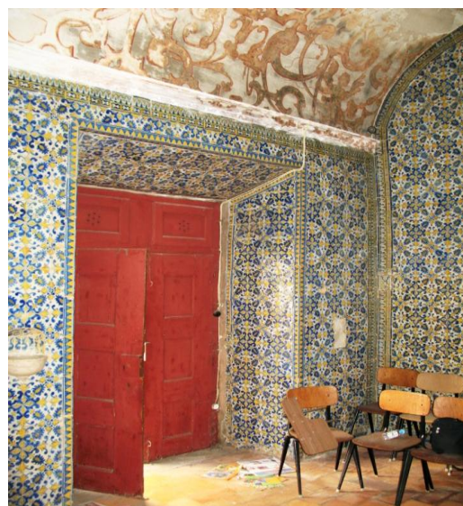
Fig. 28 Entrada da Capela de São Manços e pormenor do revestimento a azulejos.
