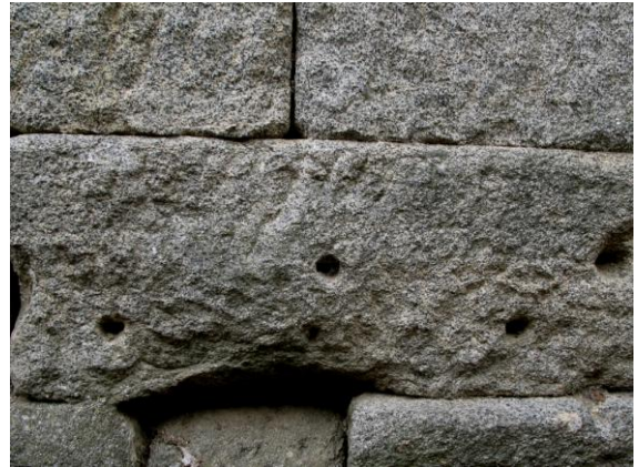
Fig. 17 Silhar romano com vestígios de buracos de fórceps na parede Este do Mausoléu na Igreja Paroquial de S. Manços (Évora).
