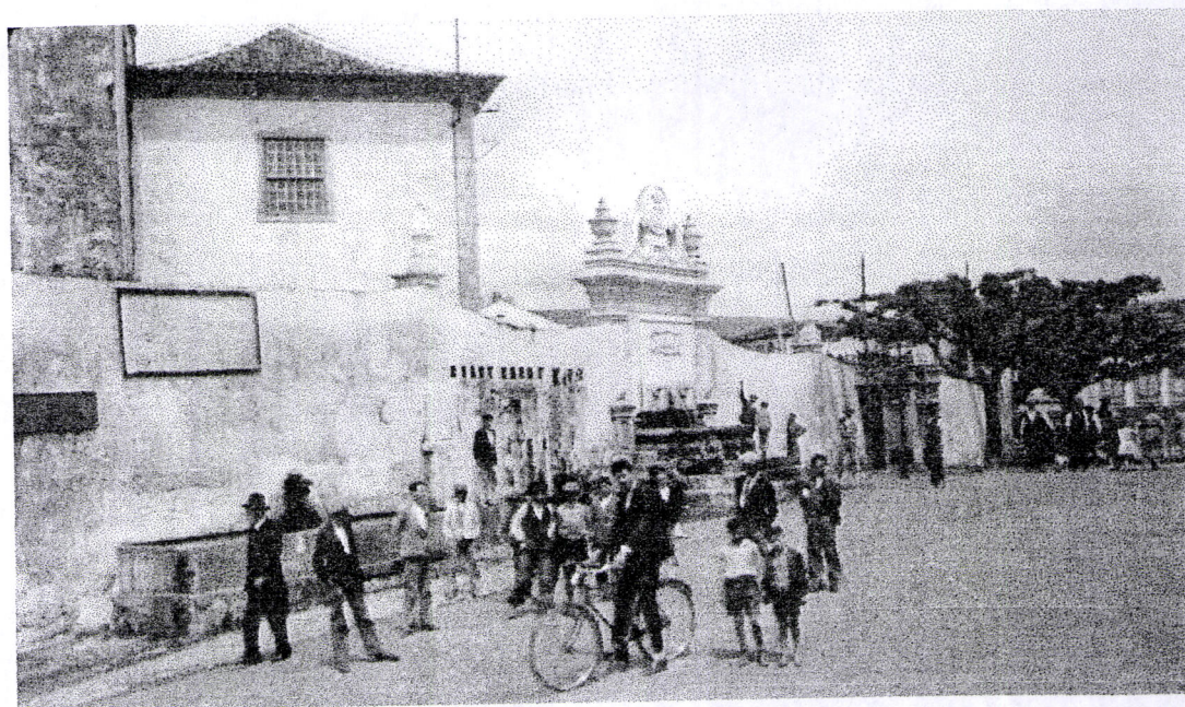
Fig. 247. Alto das Covas, em Angra do Heroísmo. Muro do Convento da Graça, antes da sua demolição, em 1937.
