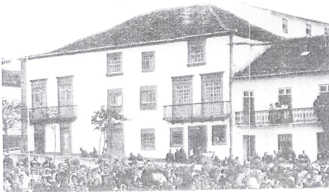
Fig. 13. "Casas do Corvelo", em Angra do Heroísmo. Edifícios demolidos (fotografia de c.1908)
