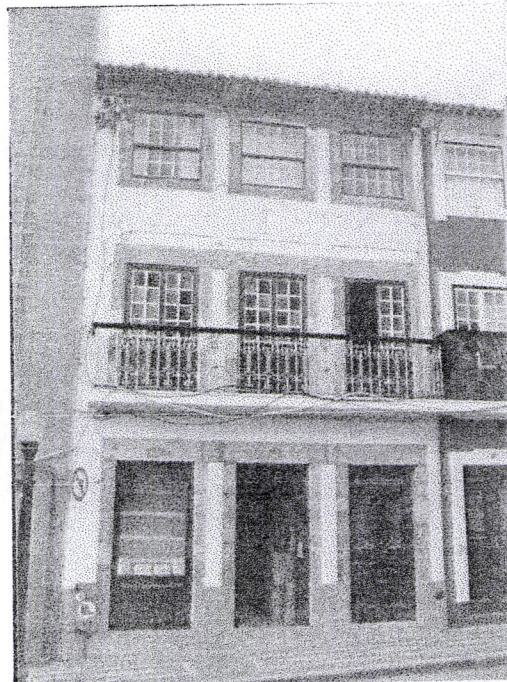
Fig. 210. Caixa Geral de Depósitos, em Angra do Heroísmo (fotografias de 1980). Segundo projecto. Edifícios do século XVIII anexos adquiridos para ampliação das instalações. Em cima, edifício com os números de polícia 137/141. Em baixo, edifício com os números de polícia 133/135.
