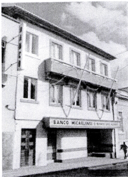
Fig. 50 “ Casa do Camacho “, em Angra do Heroísmo . Edifício com as primeiras alterações introduzidas pelo Banco Comercial dos Açores (fotografia de 1980).
