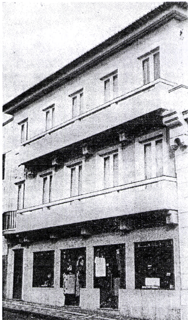
Fig. 46. "Casa do Camacho", em Angra do Heroísmo. Edifício de 1954
