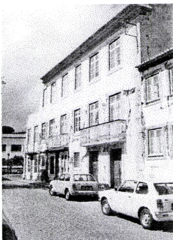
Fig. 76. “Casa do Severo Moniz” em Angra do Heroísmo. Edifício demolido. Alçado da Rua Recreio dos Artistas (fotografia de 1980).
