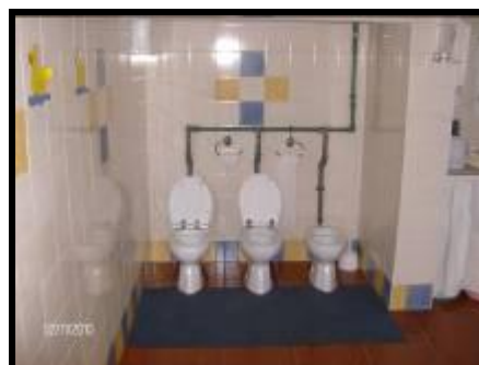
Fig. 4 – Sanitas da casa de banho de Creche
