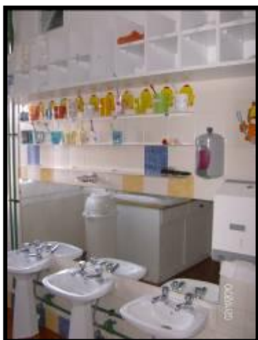
Fig. 5 – Lavatórios da casa de banho de Creche
