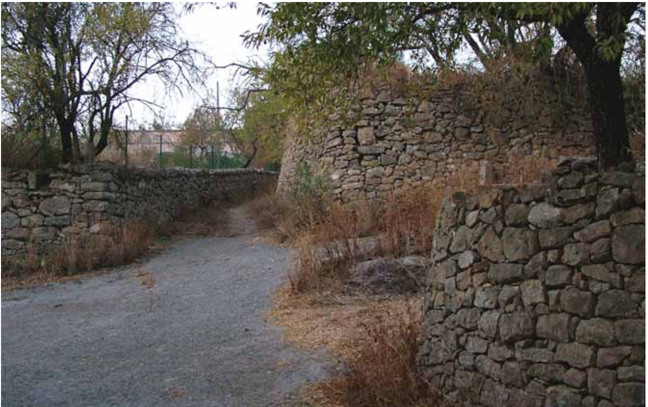
Muros de suporte em pedra solta. São Faustino, Loulé.
