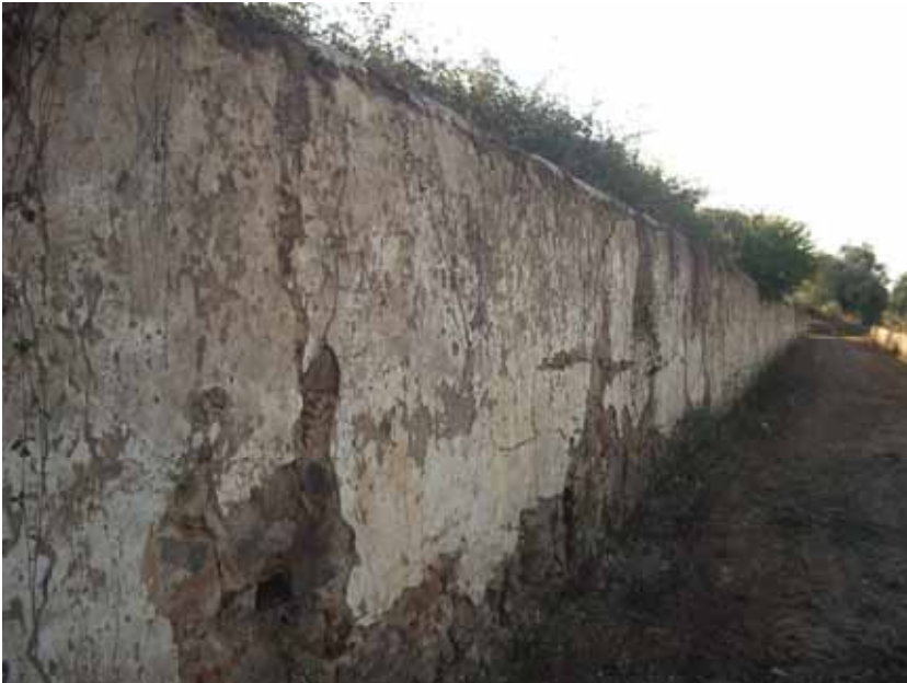
Muro em alvenaria de pedra. Aljoz, Silves.
