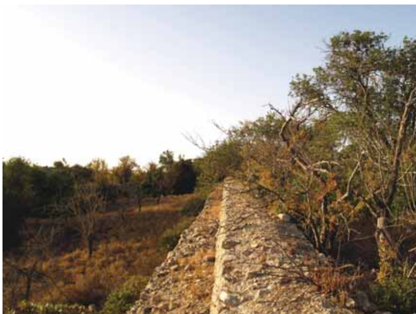
Muro combinado. Tunes, Silves.
