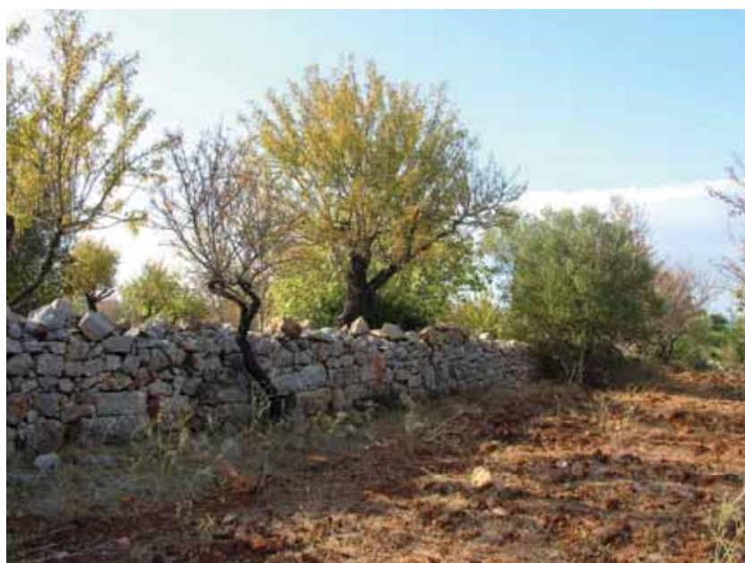
Muro de limite. M8 - 1,40x0,90 m (interior 0,65 m).
