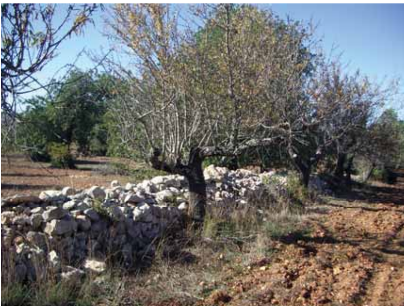
Muro de limite . M6 - 1,20 a 1,50x0,80 m (interior 0,60 m).
