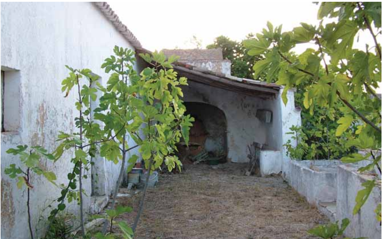
No topo, vista da escada que conduz à açoteia e da porta de acesso ao palheiro. Em cima, pátio traseiro com casa do forno ao fundo.
