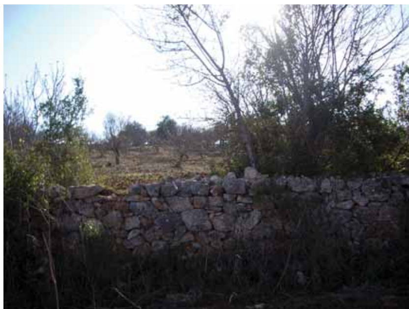
Muro de limite. M7 - 0,90x0,80 m (interior 0,40 m).
