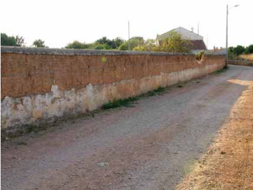
Muro de taipa. Aljoz, Silves.
