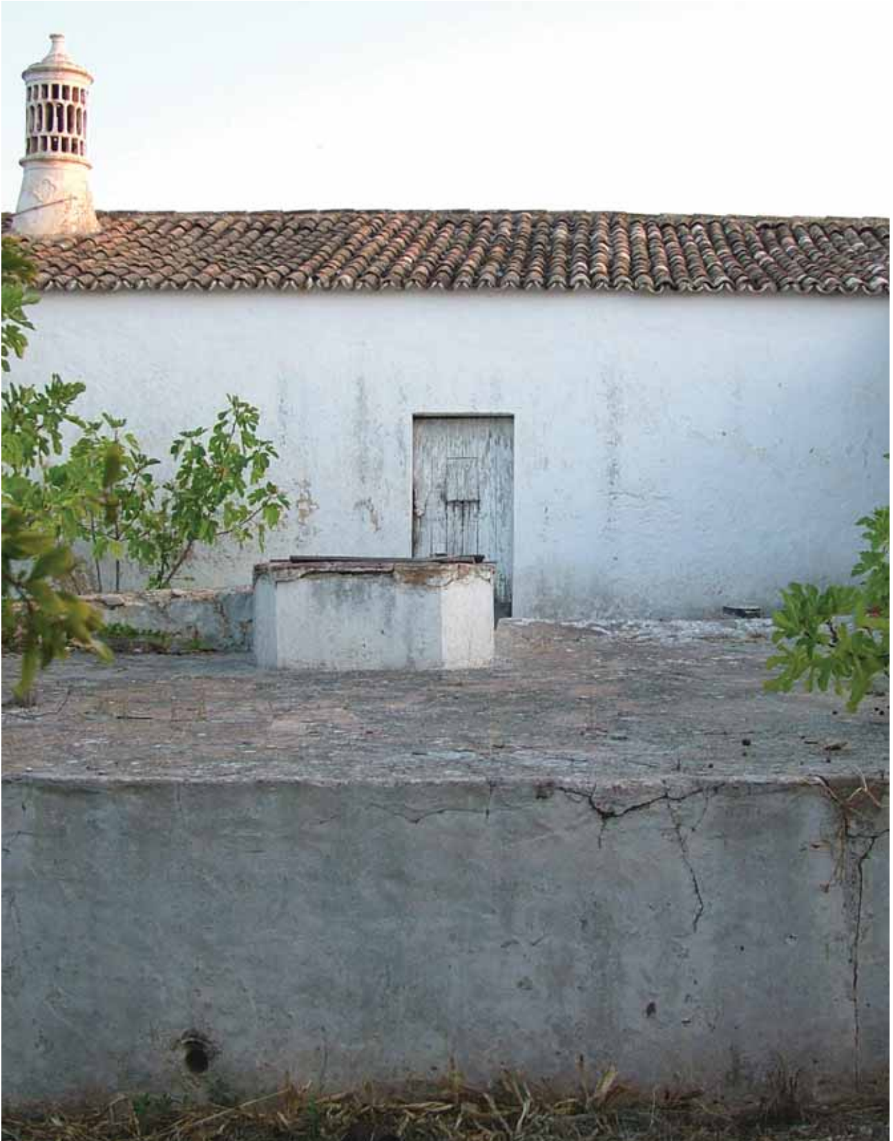
Vista do eirado da cisterna.
