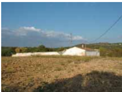
Vista da fachada oeste.
