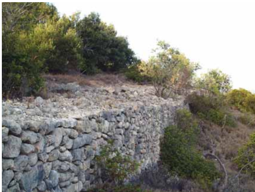
Muro de contenção de terras. Tunes, Silves.
