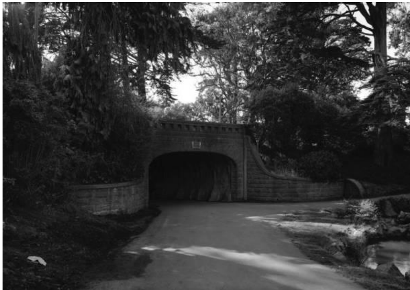
Figura 1: Alvord Lake Bridge, primeira ponte de betão armado do mundo, construída em 1889 [01] .
