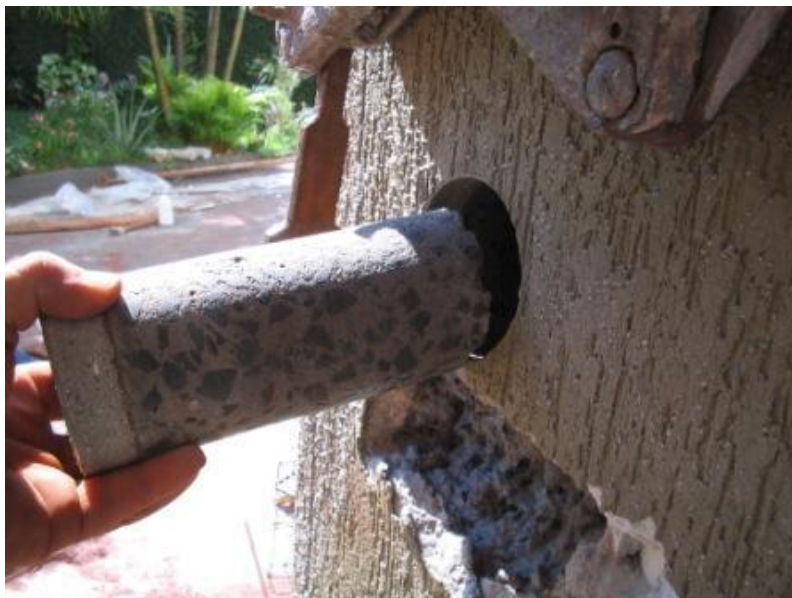
Figura 57: Extração de uma carote de um pilar de betão para a medição da profundidade de carbonatação [38].
