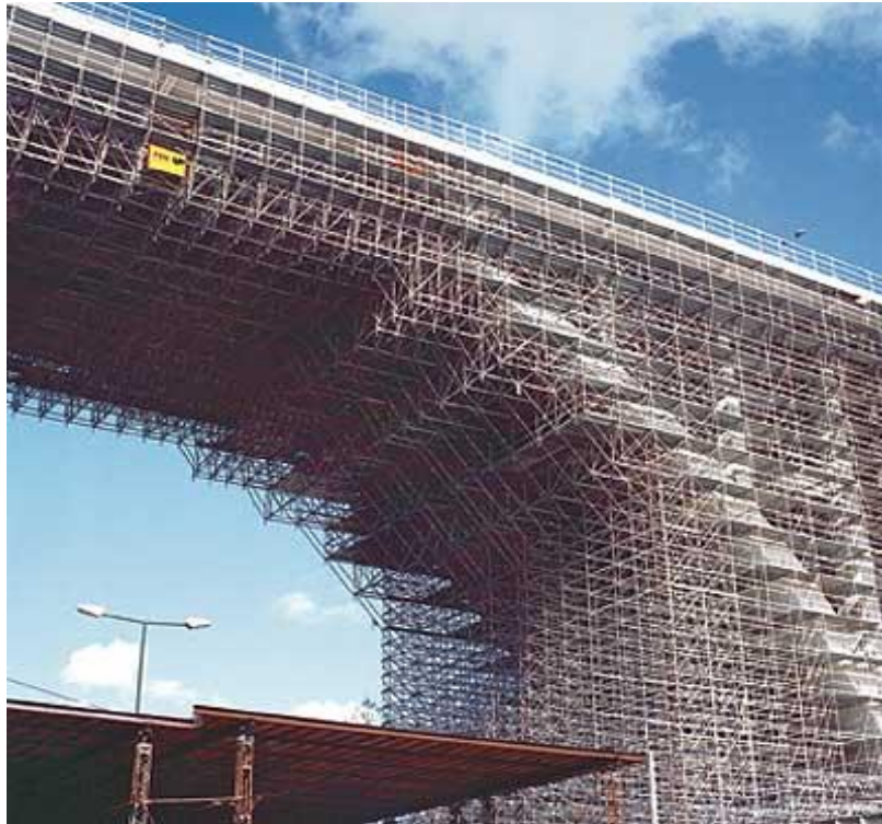
Figura 95: Obras de manutenção no Viaduto Duarte Pacheco em Lisboa 159] .
