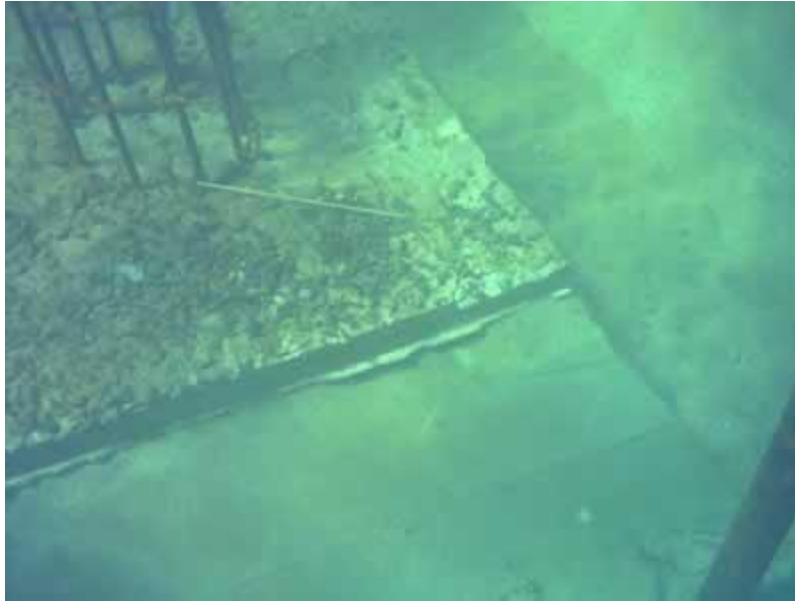
Figura 33: Reparação de uma estrutura de betão no fundo do mar [21] .
