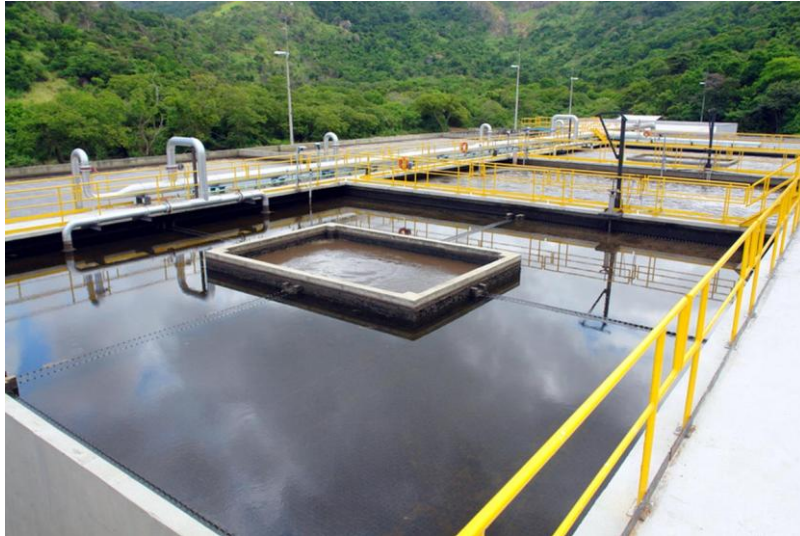
Figura 48: Central de águas residuais, onde os ataques bioquímicos são o principal agente patológico no betão [32].
