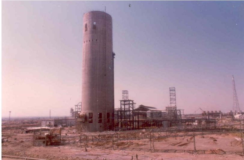
Figura 44: Construção de uma torre-silo numa fábrica de Fertilizantes nos EUA (1996) [30] .
