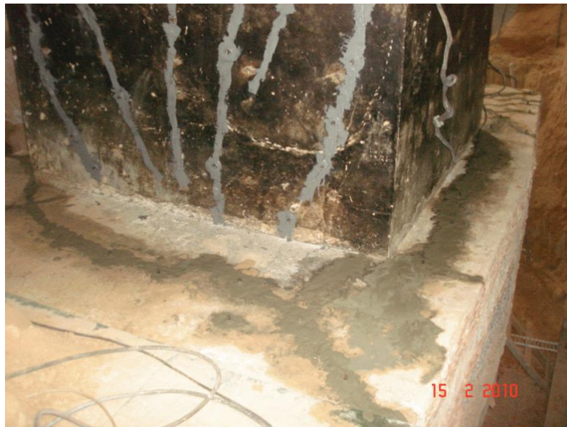
Figura 65: Reparação da fissuração provocada por reações expansivas internas [44].
