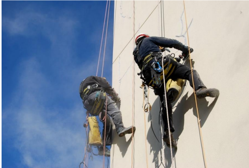
Figura 12: Reparação das fendas existentes num pilar de um viaduto [09].
