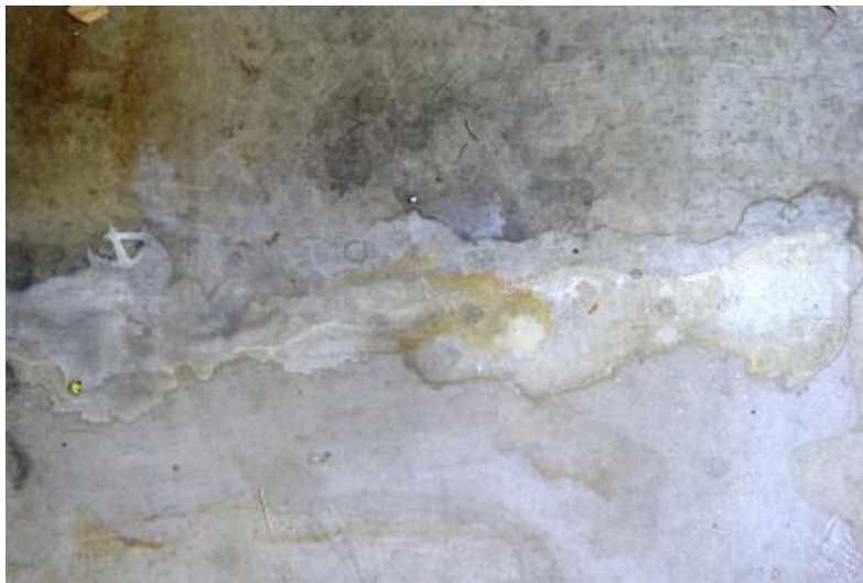
Figura 37: Ataque provocado por derramamento de ácido de baterias de automóveis, numa oficina [25] .
