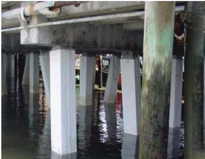
Figura 34: Utilização da Jaqueta G, produzido pela Rogertec ® , que possui uma durabilidade média de 10 a 20 anos para a proteção contra a ação da água do mar no betão [22] .
