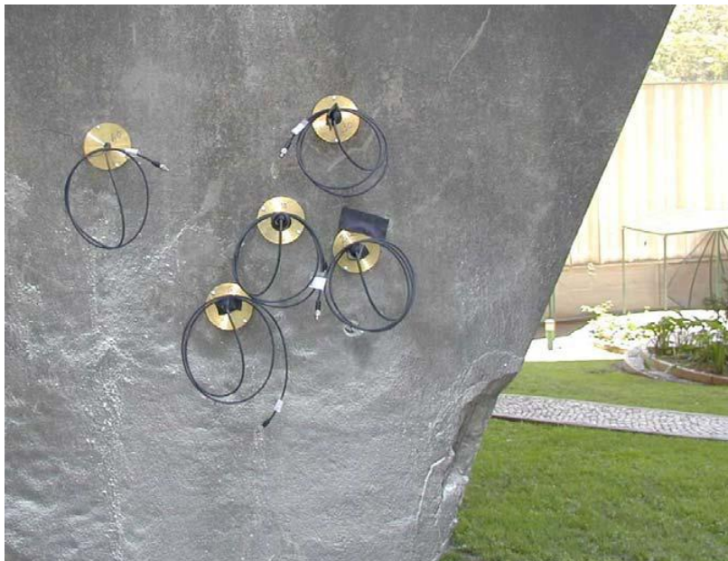
Figura 97: Medição da humidade no interior do betão [58] .
