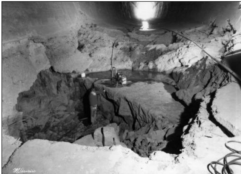
Figura 24: Efeitos da cavitação, Miranda, 1974 [16] .
