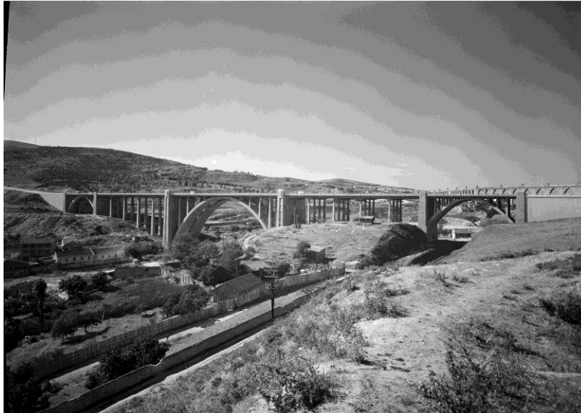
Figura 93: Viaduto Duarte Pacheco após a sua conclusão [57].
