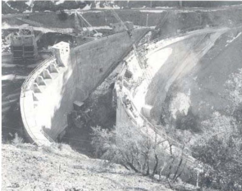
Figura 28: Substituição da barragem Drum Afterbay nos EUA em 1966 [18].
