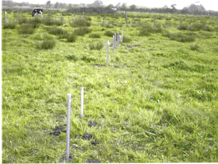
Figura 20 - Aspecto da instalação da bateria de piezómetros, no Baixo Vouga Lagunar.
