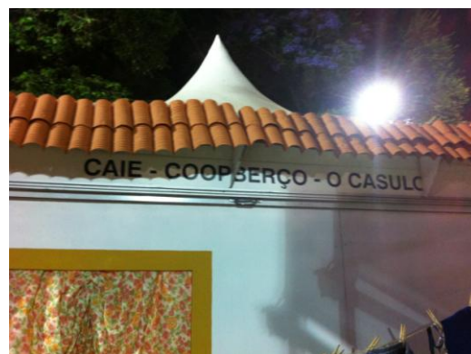
Fig.8 – Telhado elaborado com garrafas de água de 1,5L.
