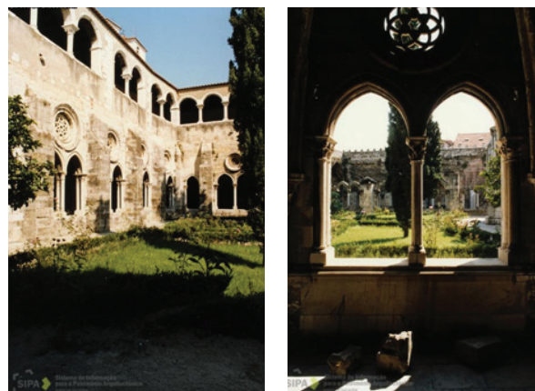
Figuras 129, 130 e 131 - Claustro da Sé Catedral de Lisboa, antes das escavações (as duas primeiras imagens mostram uma vista de nordeste, a terceira de Sul). (Adalberto Dias Arquitetos, 2013)
