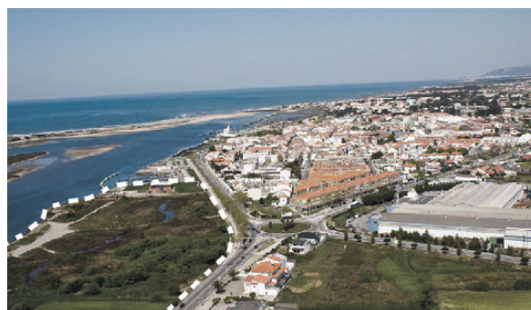
Figura 7 - Vista aérea de parte da área de intervenção em direção ao seu limite norte, na qual é possível observar a relação do futuro Parque com a cidade de Esposende. Na área de intervenção são bem visíveis os resquícios do Amial, alguns dos esteiros do Cávado que banham a zona de sapal bastante degradada e ao fundo o CANE.
