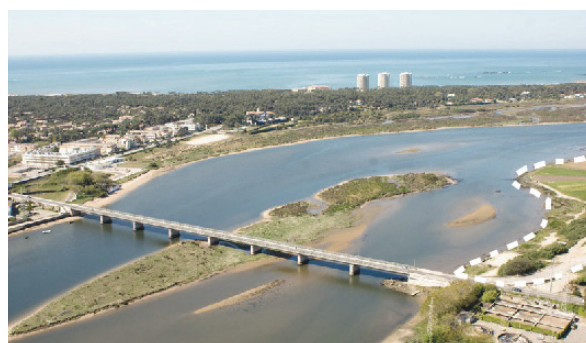
Figura 6 - Vista aérea de parte da área de intervenção a partir do limite sudeste em direção a noroeste, na qual é possível observar as torres de Ofir, o impacto que estas têm na paisagem e a sua relação com a margem oposta. Em primeiro plano é possível ver a ETAR e novamente a ponte D. Luís Filipe.
