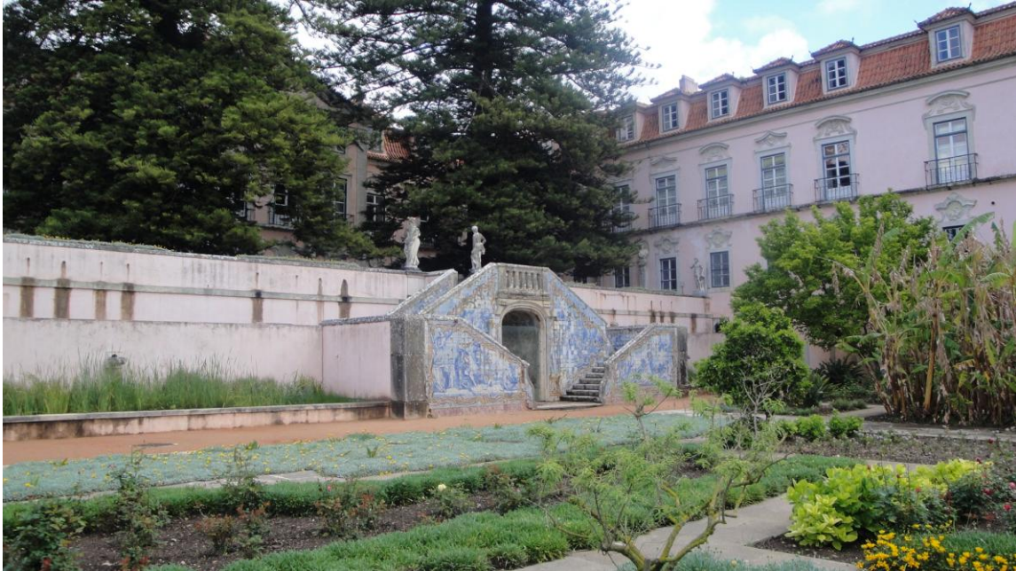
Fig. 9 – Escadaria revestida de azulejos
