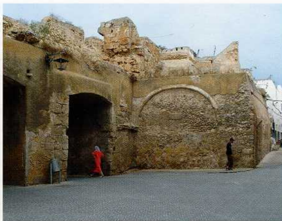
Vestígios da porta anterior da antecâmara de acesso ao Baluarte do Governador, sob o reparo Foto: João Barros Matos
